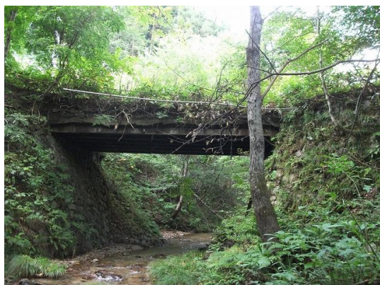
参考写真-1② 2 代目旧西川橋、西川下流側から望む、右福島側、主桁はメタル(鋼製)。高欄(欄干)なし。 H230908 撮
