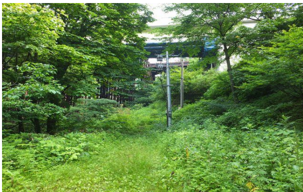
写真-1④ 蛇体道入口付近。国道 13 号3代目西川橋真下から望む。見えている橋梁は東北中央自動車道、新西川橋(4代目)で背後は工事用の仮橋。この後しばらく藪こき。
