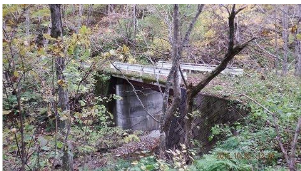
参考写真-1③ 「烏川林道」林道橋7号橋梁、横川(本川烏川)に架かる。蛇体鉾山から約2.3km梨平側、八百沢から約0.7km大滝側の地点。 山口屋散人さん提供 H271027
