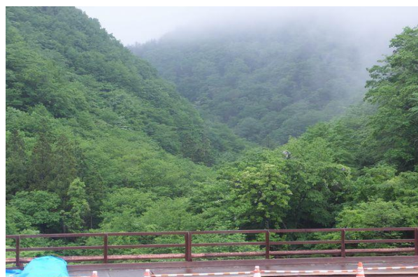
参考写真-2④ 新西川橋から蛇体道(右側林の中)クビト峠方向を望む。左側奥が西川本川、右側が左支川横川(クビト峠が源流) H290525
