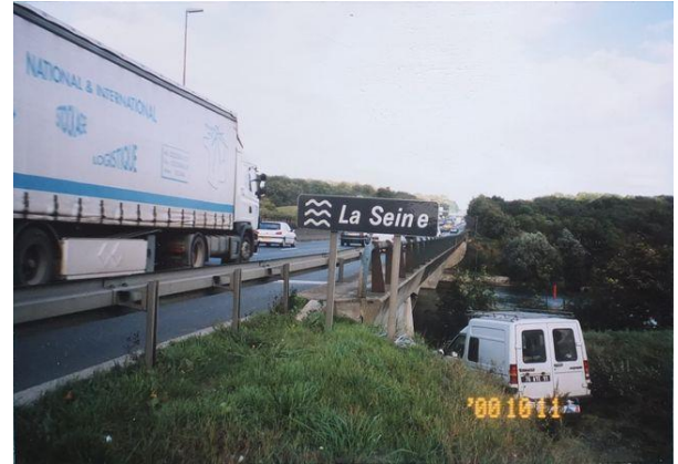
参考写真-3② フランスパリ郊外高速環状4号（国道N104）、調査をしたセーヌ川コンクリート橋梁L=200m（補修工事中）。「平成12年度欧州におけるコンクリート耐久性向上施策状況調査」。セーヌ川の標識が面白い。
