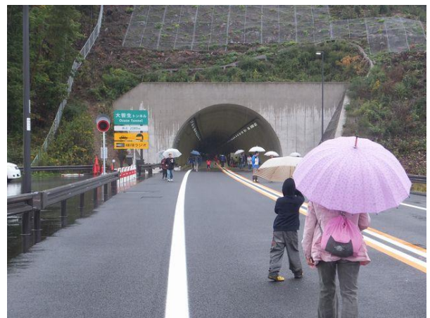
【写真-3①】 大笹生トンネル福島側坑口
