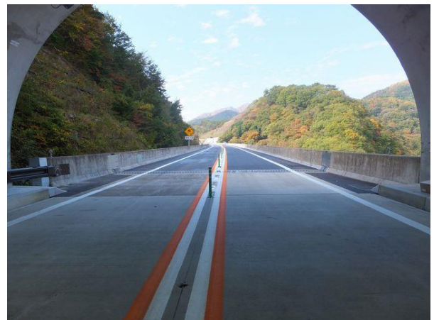
【写真-10】 朴沢大橋(L=315m)、福島側(A1)から米沢側(A2)を望む。
