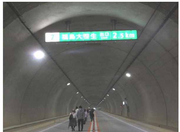
【写真-4⑦】 トンネル内案内標識
