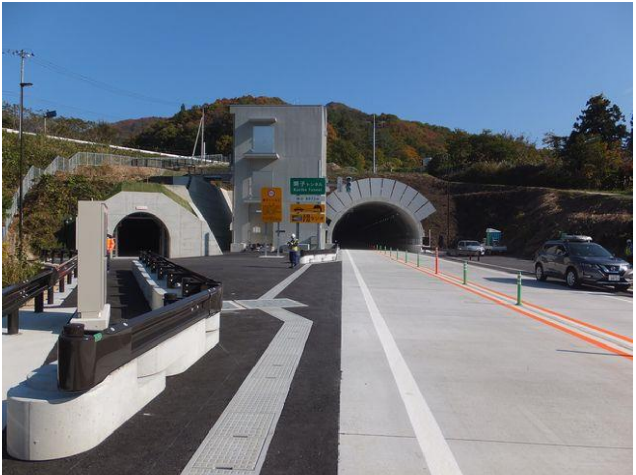
【写真-11③】 栗子トンネル(L=8,972m)米沢側坑口を望む。左は避難用トンネル。中央の建物は栗子トンネル電気室(山形側)。
