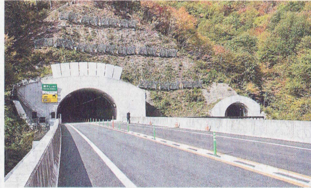
栗子トンネルの福島側の入り口(左)。右は避難用トンネル
