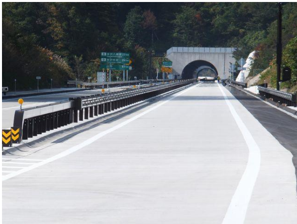
【写真-7】 新高平トンネル(L=499m)福島側坑口を望む。
