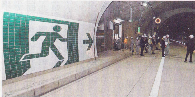
栗子トンネルから避難用トンネルに続く非常口
