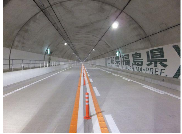
【写真-11②】 栗子トンネル内福島・山形県境、山形県側を望む。(福島県分 L=5417m、山形県分 L=3555m)
