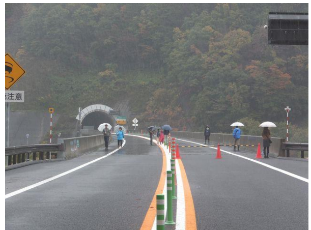
【写真-5②】 小川大橋(L=243m)と沖根山トンネル(L=919m)。大笹生トンネル米沢側坑口から望む。
