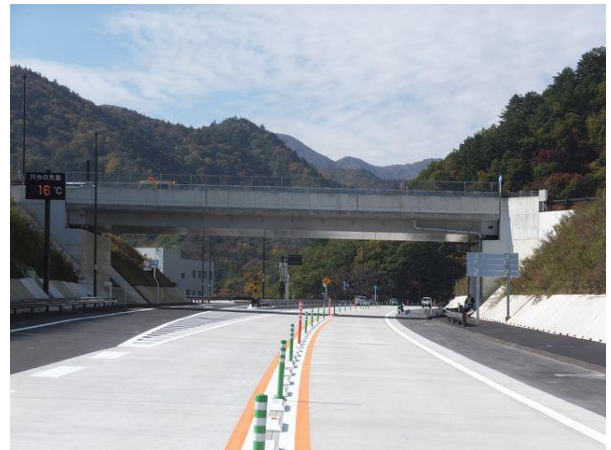
【写真-8】 大滝地区、栗子跨道橋(L=28.6m)防災ステーション付近(大滝チェーンベース)。米沢側を望む。
