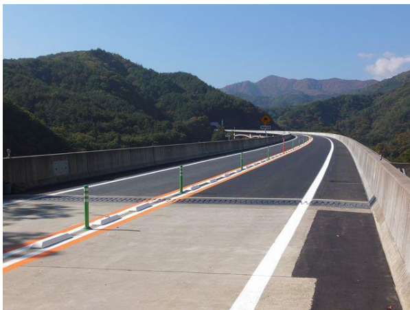
【写真-9】 中野大橋(L=754m)、福島側から米沢側を望む。
