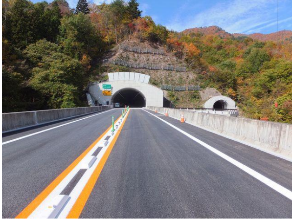
【写真-11①】 栗子トンネル(L=8,972m)福島側坑口を望む。右は避難用トンネル(L=8,989m)。手前、新西川橋(L=77m)H291027
