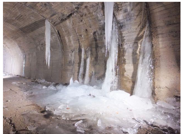
写真-2① 福島側最初の氷柱群（左側）。漏水が吹き出している。
