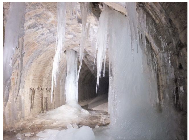
写真-8④ 中間部巨大氷柱天井部及び奥の氷柱、福島側から望む。
