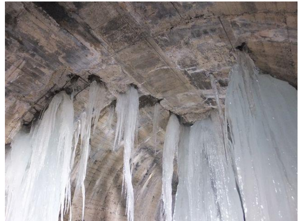
写真-8② 中間部巨大氷柱天井部、米沢側から望む(2)
