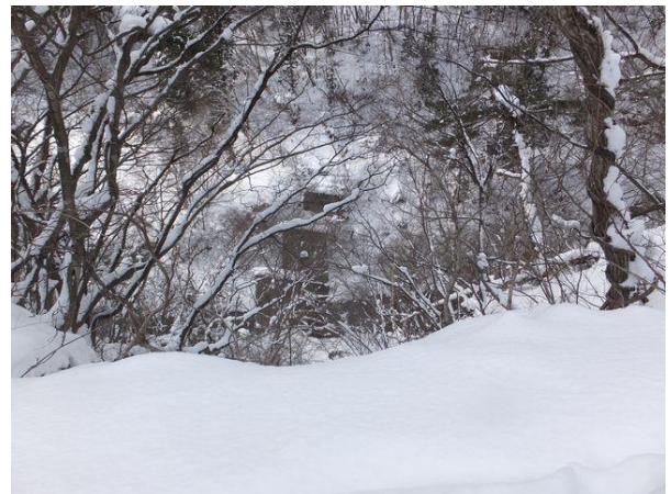
(写真-5②)2代目山神橋下部工遺構(推定:L=44m、 W=6.5m、S4 架換)を望む。 現国道13号3代目山神橋、小川左岸 下流、横川林道国道向側市道から望む。
