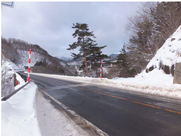
(写真-5①)現国道13号3代目現在の山神橋 (L=106.6m、w=8.0m、S38.11 完)。 右上東北中央自動車道(E13)中野大橋。 右スノーポール箇所横川林道起点。 福島側から米沢側を望む。
