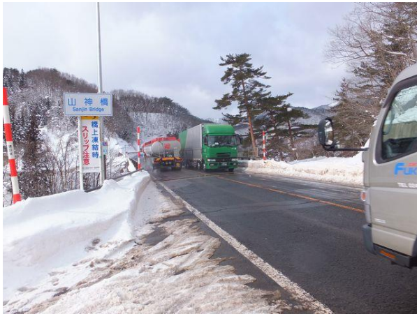
(写真-7) 現国道13号、危険物積載車両の通行が目立つ(栗子トンネル通行禁止)。 1日あたり交通量(開通1ヶ月平均):現国道13号 8,000台→2,300台に減少。 E13を含めると12,400台(4,400台増加) H300131 国交省発表
