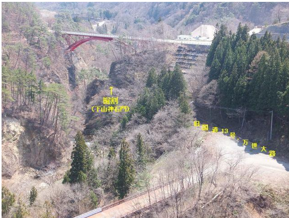
【参考写真-1②】 中野大橋中央部から小川の下流側を望む。赤いアーチ橋は、現国道13号の山神橋である。下の道路は旧国道13号で手前の仮橋は、中野大橋施工のための工事用道路である。H280406
