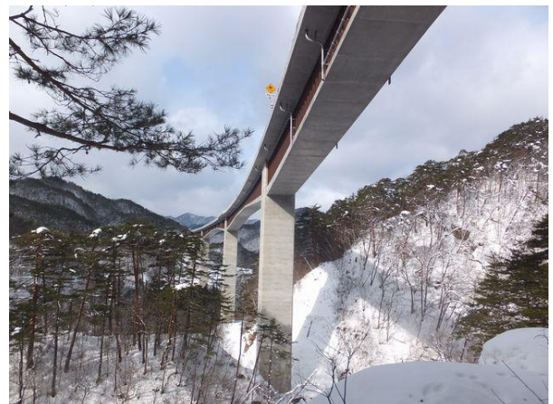
(写真-6①)東北中央自動車道(E13)中野大橋 (L=754m、w=10.5m、H24.2 完成)、 横川林道から望む。
