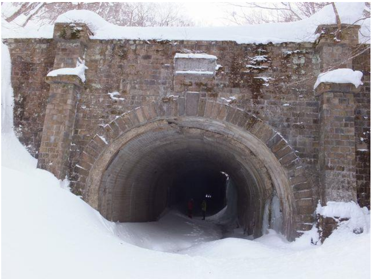
写真-10③ 米沢側坑口
