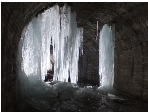
写真-7② 中間部巨大氷柱群、福島側を望む。
