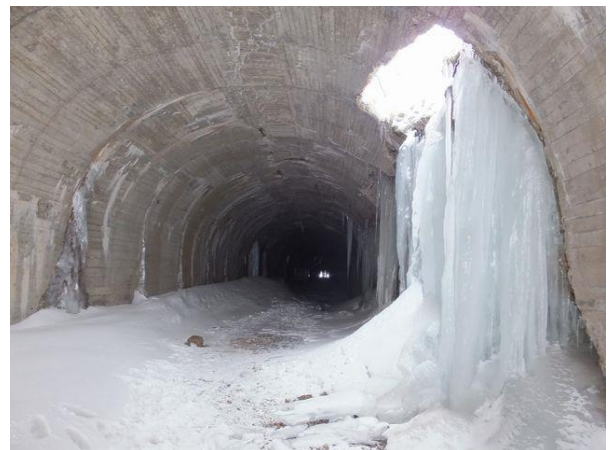
写真-9④ 米沢側坑口水柱群、福島側を望む。
