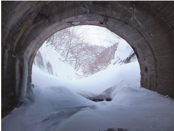
写真-10① 米沢側坑口
