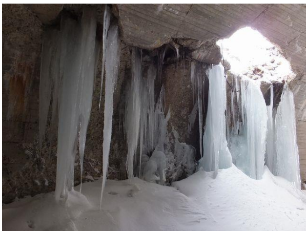
写真-9① 米沢側坑口水柱群
