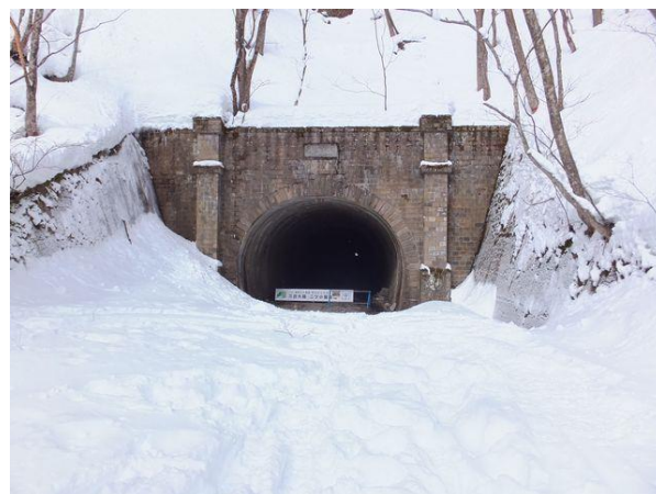
写真-1② ニツ小屋隧道福島側坑口（L=384m）
