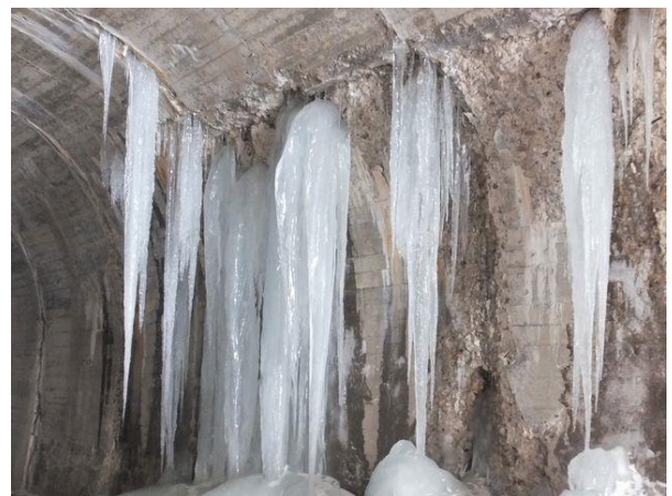
写真-9② 米沢側坑口水柱群
