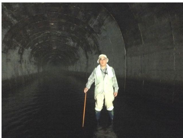
写真-8② 栗子隧道坑内にて。 坑口から 50m 付近、米沢側を望む。
