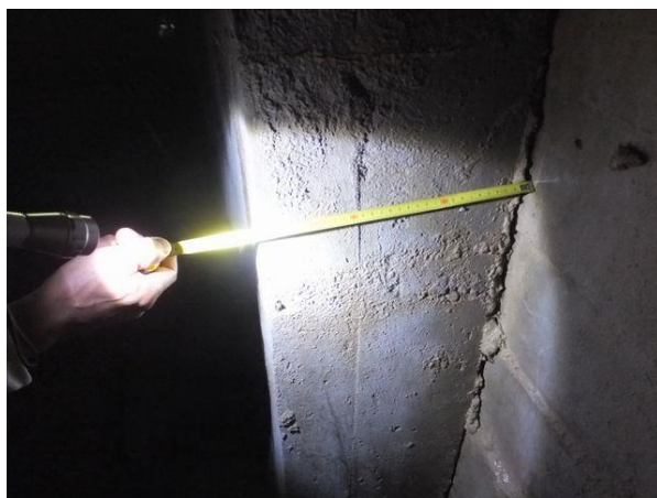
写真-8③ 内巻補強 坑口から 100m 程度、厚さ 30 cm。
