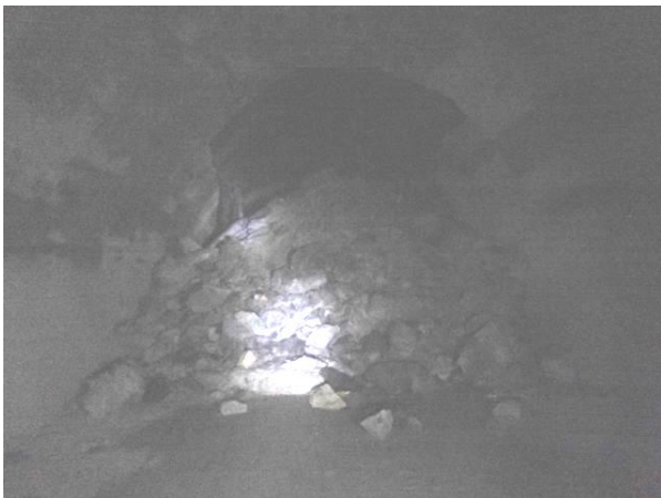
写真-8⑧ 大崩壊箇所
