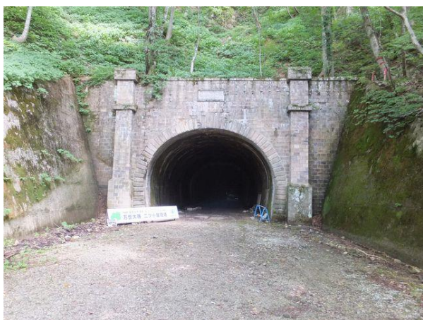
写真-1① ニツ小屋隧道福島側坑口
