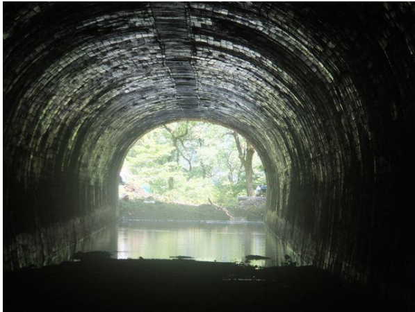
写真-9② 栗子隧道福島側坑内より湛水線を望む。
