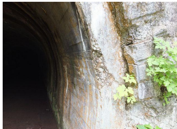
写真-7② 栗子隧道福島側坑口、内巻部。 骨材川砂利使用、戦後の補強か。
