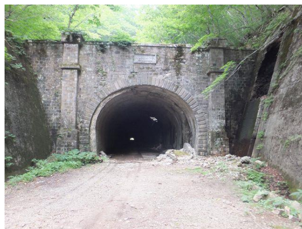
写真-1② ニツ小屋隧道米沢側坑口
