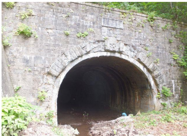
写真-7① 栗子隧道福島側坑口
