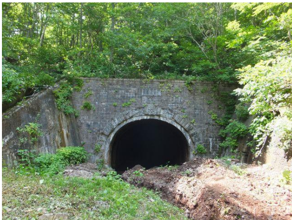
写真-10① 栗子隧道福島側坑口 (L=870m)
