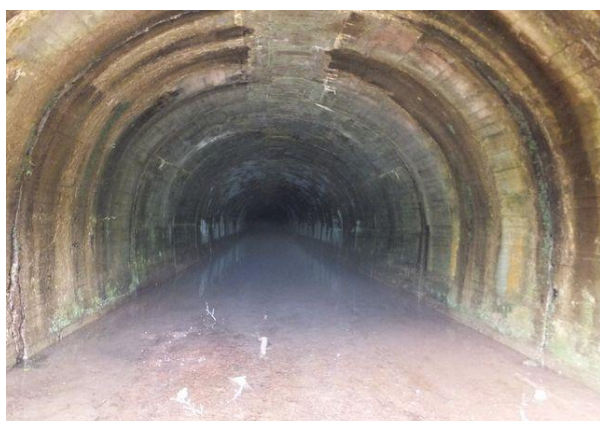
写真-7③ 栗子隧道福島側坑口から望む。
