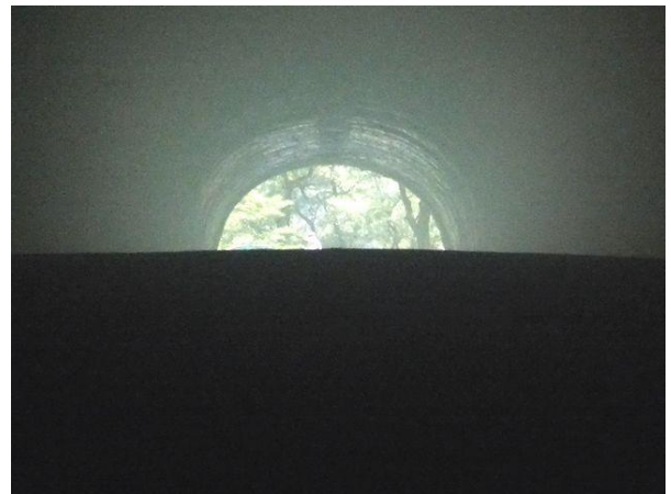
写真-9① 中央黒線栗子隧道クラウン部(福島側から 400 m付近、H=888m、明治隧道貫通点)。県境付近から福島側坑口を望む。
