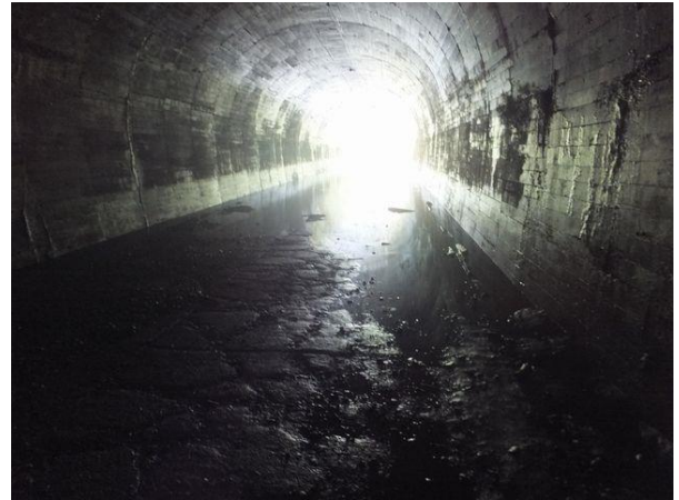
写真-9③ 湛水線付近から坑口を望む。
