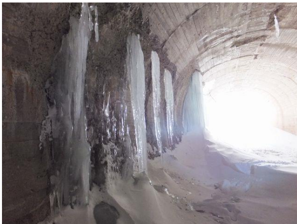
写真一11① 米沢側坑口「明り巻」区間（推定）左側（南側）の巨大氷柱群。手前に「大きなつらら」列、奥が覆工崩落開口部の「巨大氷柱群」。米沢側坑口を望む。
