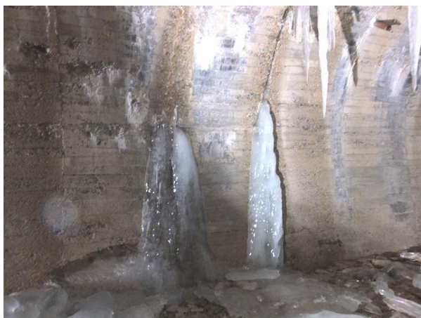
写真-2③ 湧水箇所、北側(左)氷柱。福島側から望む。 H290212
