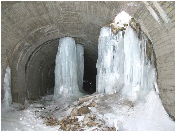
参考写真－10① 二ツ小屋隧道米沢側坑口巨大氷柱、平成 23 年 2 月撮影。写真－12 とほぼ同一箇所。米沢側坑口から福島側を望む。H230206
