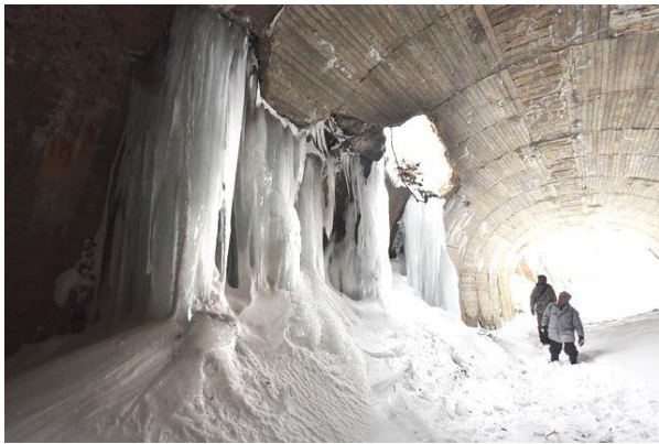
写真-11③ 米沢側坑口「明り巻」区間の巨大氷柱群。 覆工崩落開口部の「巨大氷柱群」。 矢内晴史様提供
