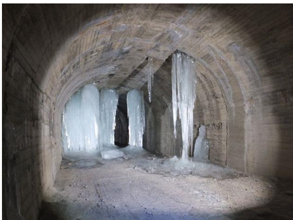
写真-5① 巨大氷柱群(第2号内巻区間)、米沢側から望む。H290212
