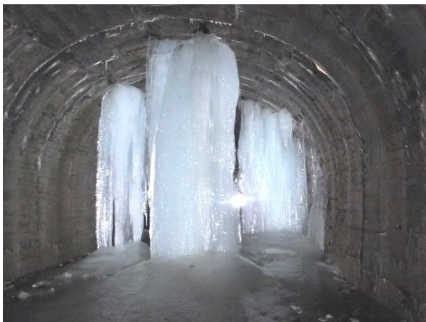
写真-4② 巨大氷柱群、福島側から望む。福島側坑口から約80m(推定)地点。巨大氷柱は、写真左奥(南側)、中央、右奥(北側)の3箇所。
