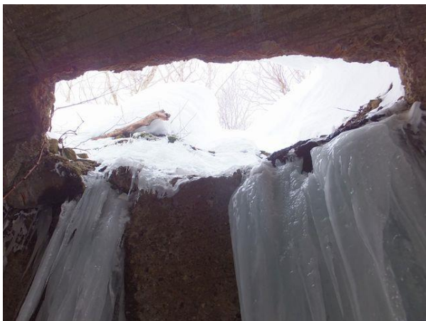
写真-11⑤ 覆工崩落開口部
