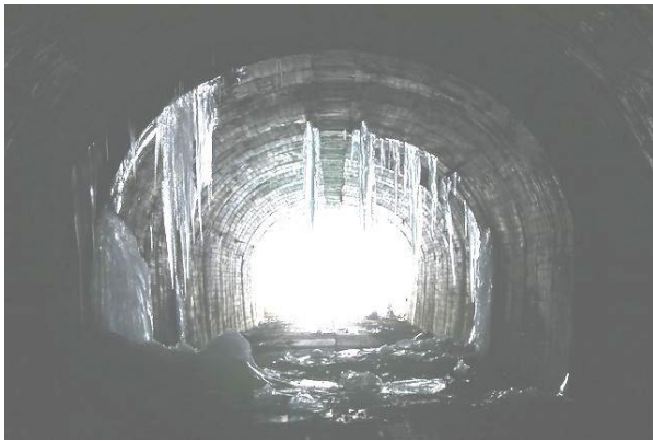
写真-2⑥ 福島側坑口第1号内巻米沢側端部付近から福島側を望む。dark-RX 様提供
