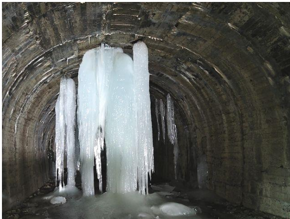
参考写真－6① 平成23年2月撮影、写真－4①とほぼ同一構図。米沢側を望む。おばら様提供 H230206
