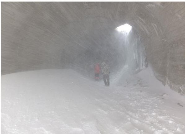
写真-13③ 米沢側坑口付近の覆工開口部と坑口からの強烈な地吹雪の吹き込み。 H290212
