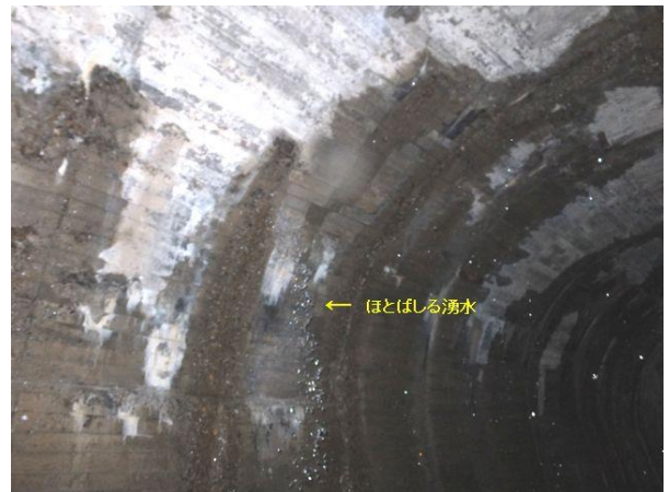
参考写真-2 第 1 号内巻区間、左側側壁からほとばしる湧水。 写真-2③箇所。 H251027
