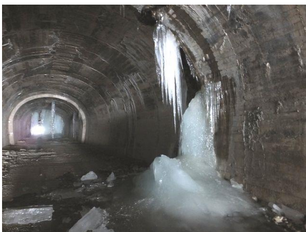
写真-2④ 第 1 号内巻区間端部（米沢側）、北側（右側）氷柱。奥に第 2 号内巻端部が見え天井からの「2本つらら」（写真-3参照）と巨大氷柱群が見える。米沢側を望む。
