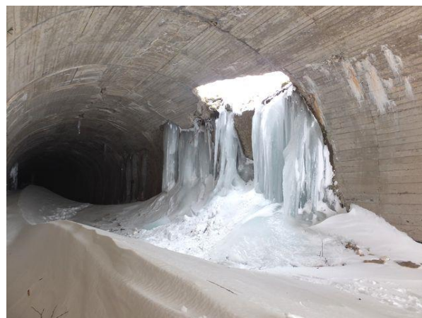
写真－12 覆工崩落開口部付近の「巨大氷柱群」。米沢側坑口から望む。平成 23 年 2 月撮影写真(参考写真－10①)とほぼ同じ構図、写真左側の天井中心から小さな「つらら」が 1 本微かに見える。
