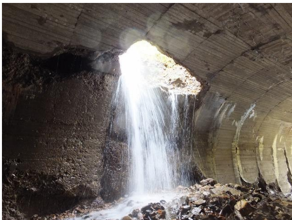
参考写真-9② 覆工崩落開口部から流れ落ちる沢水 (白竜沢流末)。H251027
