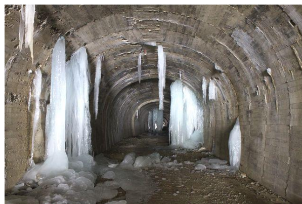
参考写真-1① 平成23年2月撮影、写真-2②と同一構図。左(南側)と右(北側)の氷柱がH29より大きい。美しく特徴ある凹凸表面の氷盤が写真左手前に見える。 sunnypanda 様提供。 H230206
