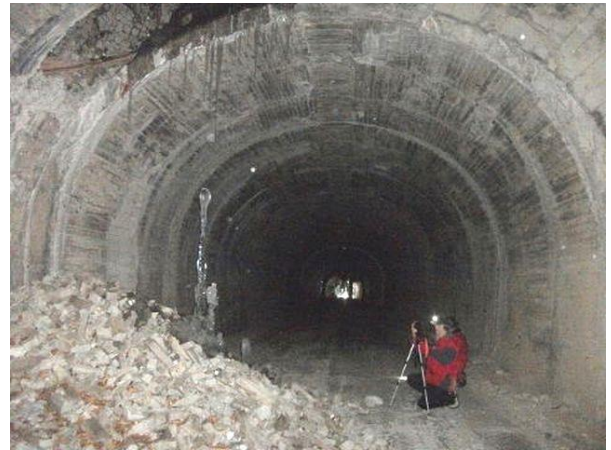
参考写真一8 平成 24 年 2 月撮影。写真一9②と同一箇所（崩落土処理前）。第 3 号内巻端部（米沢側）覆工崩落箇所。この年、氷筈成長。 本間様提供 H240226
