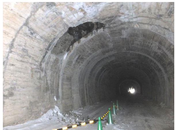
写真-9② 第 3 号内巻端部(米沢側)覆工崩落箇所。玄武岩の柱状節理露出。この下路面に氷筍形成(写真-9①)。
