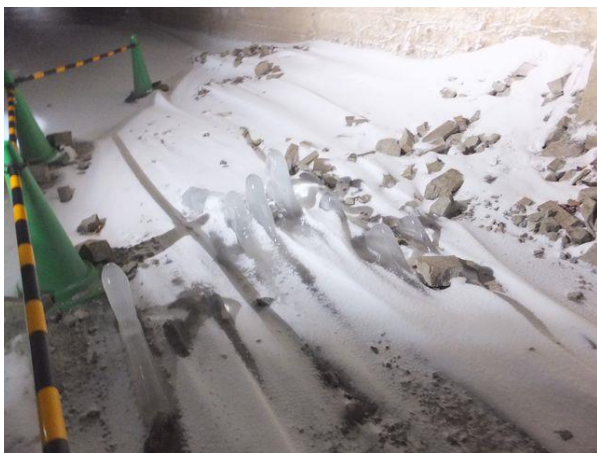
写真-9① 第 3 号内巻端部(米沢側)覆工崩落箇所の氷筍 H290212
