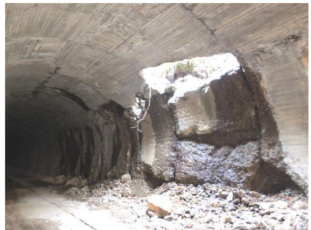
参考写真-9① 米沢側坑口付近「明り巻」区間の崩落開口部 と内巻コンクリート剥落状況。 H281106
