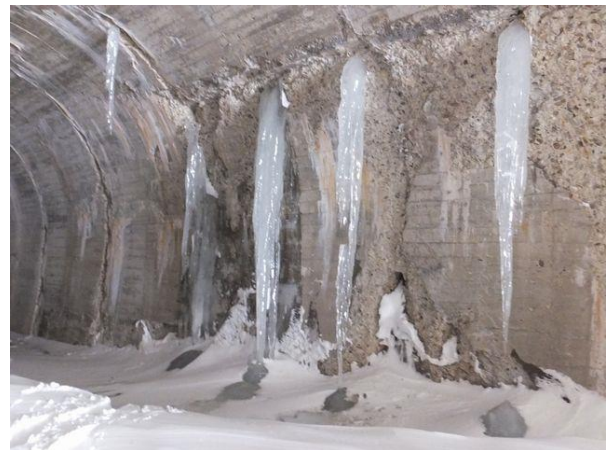
写真一11② 開口部手前（福島側）の「大きなつらら」列。内巻コンクリートが劣化し脆弱になって剥落。その箇所での漏水が「大きなつらら」を形成していると思われる。
