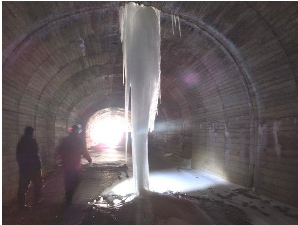
写真一10 米沢側の細めの氷柱。奥に米沢側坑口が見える。
