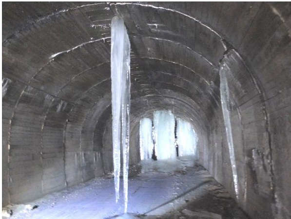
写真-3 巨大氷柱群の手前に天井中央からの「2本つらら」と右側壁部から1本つららが見える。第2号内巻起点部付近。
