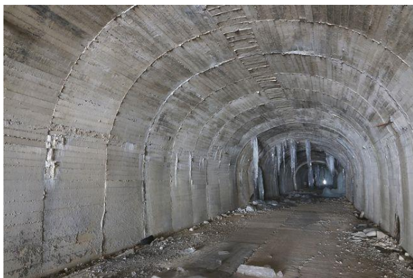
写真-2① 福島側坑口第1号内巻起点付近からトンネル奥米沢側を望む。 dark-RX 様提供
