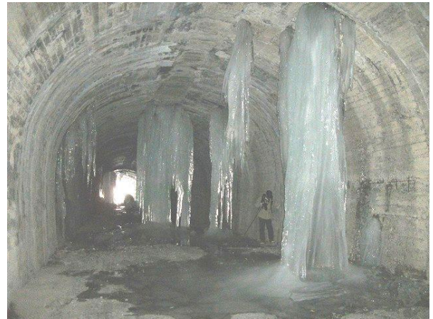
参考写真－6② 平成23年2月撮影、写真－5①とほぼ同一構図。参考写真－6①の反対側から福島側を望む。H230206
