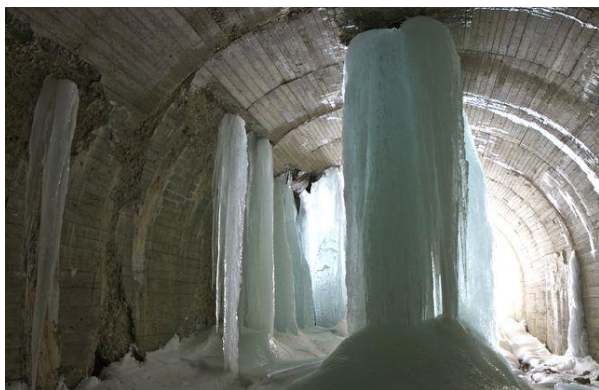
参考写真－10③ 平成 23 年 2 月撮影。参考写真－10①箇所、反対側の福島側から米沢側坑口を望む。sunnypanda 様提供 H230206
