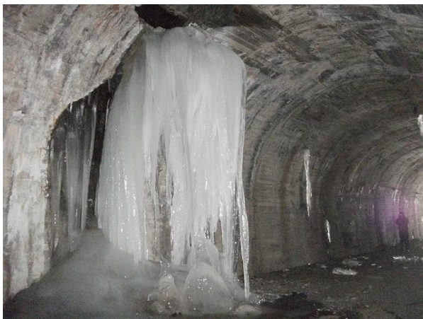
参考写真-3② 平成24年2月撮影、写真-2④同一箇所を米沢側から望む。本間様提供 H240226
