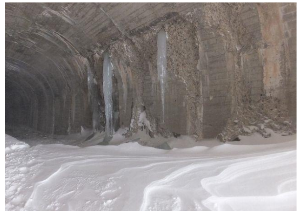
写真-13④ 覆工開口部付近の水柱下に広がる雪の風紋。 H290212
