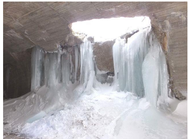
写真-11④ 覆工崩落開口部の「巨大氷柱群」。H290212
