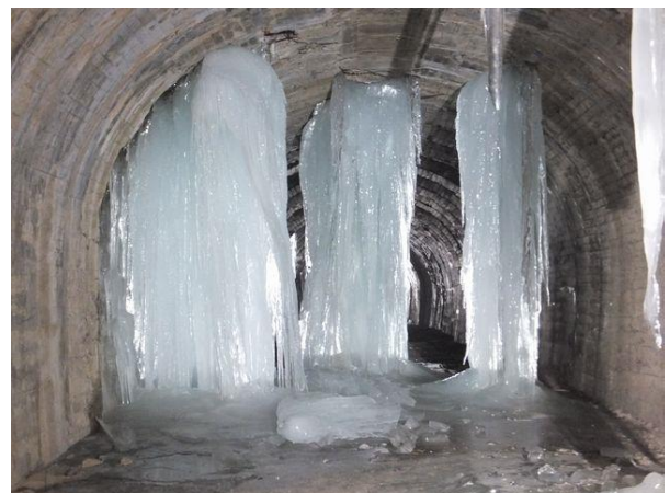
写真-5② 巨大氷柱群(第2号内巻区間)米沢側から望む。氷柱は写真左(北側)、中央、右(南側)の3箇所。H290212
