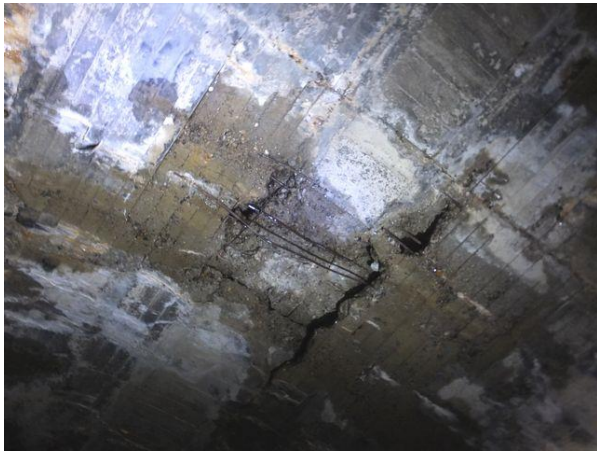
参考写真－4 巨大氷柱群箇所と思われる天井の漏水状況。第2号内巻区間で、コンクリートが剥落、鉄筋が剥き出し。H281101
