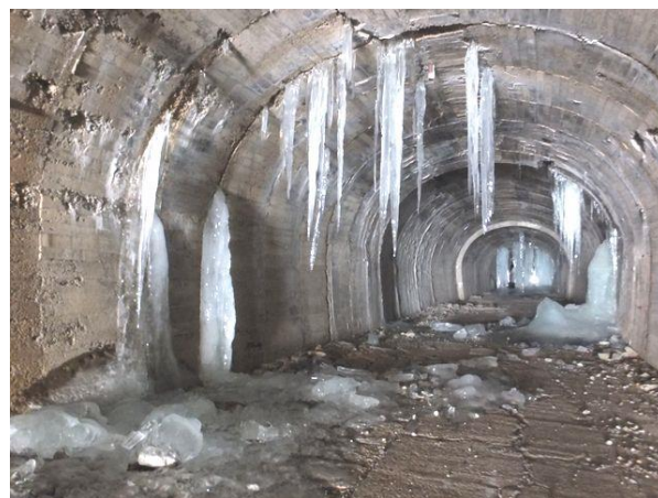
写真-2② 第1号内巻区間の「つらら」。福島側から望む。左手前(南側)湧水箇所、右奥(北側)は内巻端部氷柱箇所、奥に巨大氷柱群が見える。
