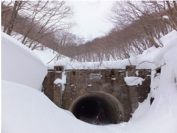
写真-13① 二ツ小屋隧道米沢側坑門。トンネルの上は谷間状の地形、白竜沢(仮称)がある。
