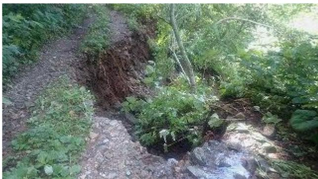
【参考写真】 平成 28 年 8 月 2 日の大雨による道路崩壊箇所（ニツ小屋隧道米沢側坑口から米沢側へ約 200m の地点、上記写真参照）。米沢側を望む。
