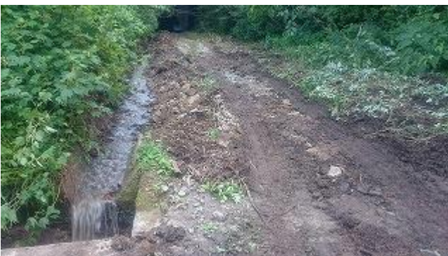
【写真—4】 ニツ小屋隧道米沢側、写真—3 の側溝の流末(既設横断暗渠箇所)。崩落箇所側から福島側を望む。 H280805
