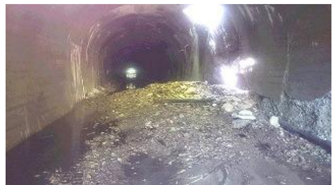
【写真-2】 二ツ小屋隧道米沢側坑口付近の覆工コンクリート崩壊箇所。トンネルの上の仮称白竜沢からの沢水流入状況。福島側を望む。H280805
