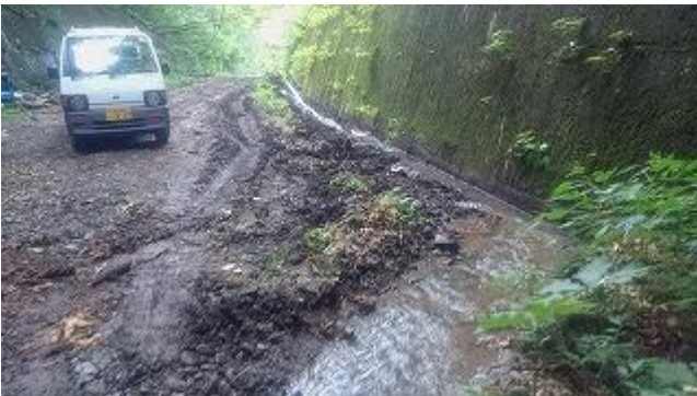
【写真—3】 ニツ小屋隧道米沢側、トンネルからの沢水を右側にある既設側溝へ切回したところ。切回し前はトンネルからの沢水が道路本体路面を流下し崩落箇所集中したと思われる。 H280805
