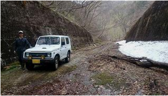
【参考写真】 ニツ小屋隧道米沢側坑口。雪解け沢水が流入し道路本体路面を流下している。 H280424
