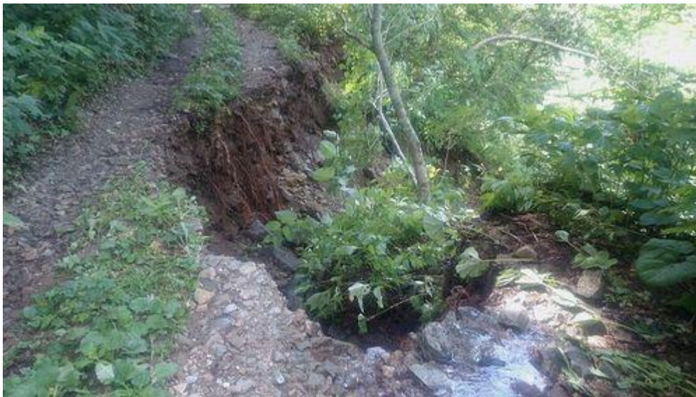
【写真-1】 8月2日の大雨による道路崩壊箇所(二ツ小屋隧道米沢側坑口から米沢側へ約200mの地点)。米沢側を望む。写真右下、道路路面から沢水が流入している。右側下は烏川。H280803
