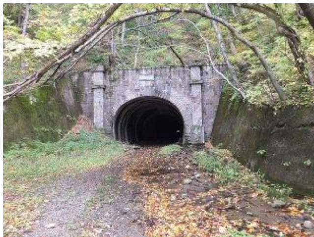
38 二ツ小屋隧道福島側坑口、右側手前に鳳駕駐蹕之蹟がある。現路面(昭和期万世大路)は、明治期万世大路路面より約2mほど盤下げされており、明治期には二ツ小屋隧道坑口付近はある程度の平地になっていたものと思われる。
