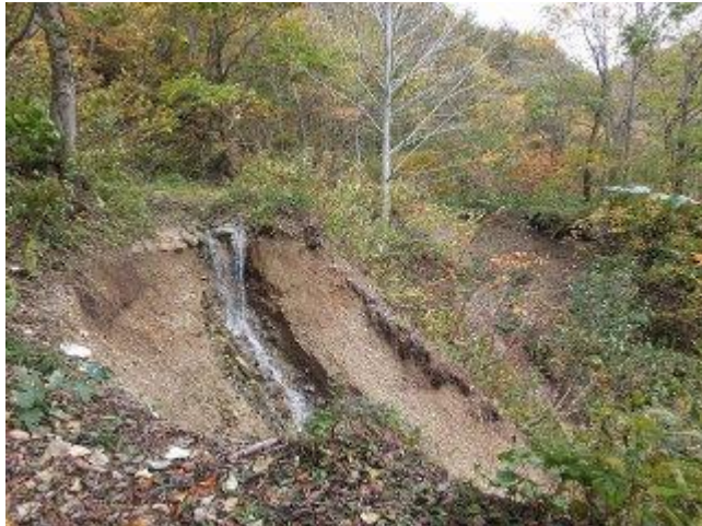
55 旧万世大路の崩壊。烏川橋から100mほど米沢側にヘアピンカーブがある。その箇所が昨年(平成24年)に崩落した。昨年は一人一人通れる幅が残っていたが、崩壊は段々進んでいるようである。福島側から望む。写真上は明治期万世大路である。
