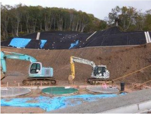
4. 栗子トンネル換気坑及び換気塔(工事中)。
