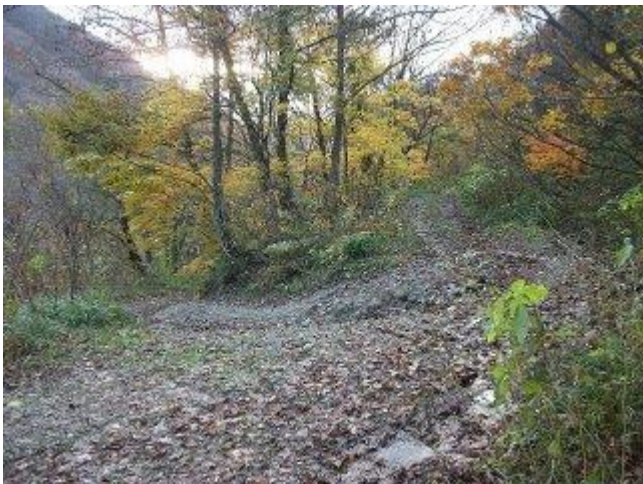
58 【参考】写真 57 とほぼ同一箇所。左側万世大路は現在崩壊(写真 59 参照)平成 22 年 11 月 6 日撮影
