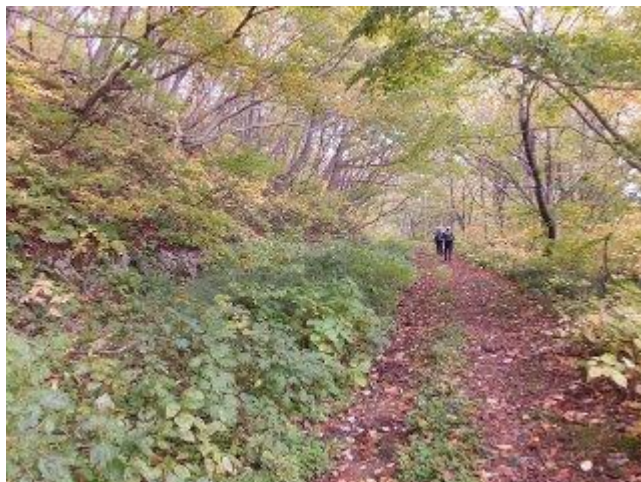
35 二ツ小屋隧道福島側、昭和期万世大路バイパス・ヘアピン道路`の中間点付近。左側に昭和の大改修で設置された石積擁壁(間知石積、空石積)が見える。
