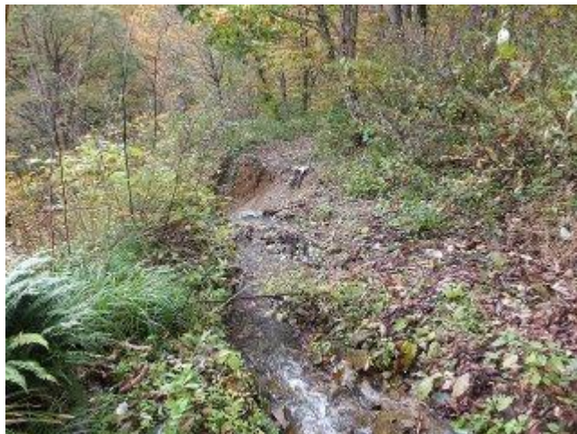
59 旧万世大路崩落箇所を米沢側から望む。 旧万世大路を流れてきた水流が崩落の原因と思われる。
