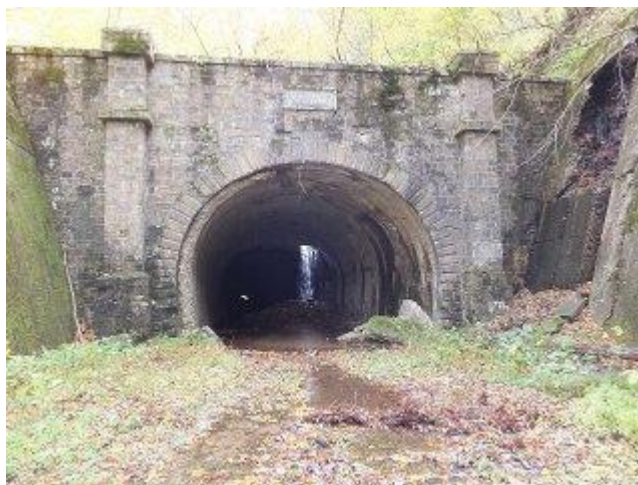
50 ニツ小屋隧道米沢側坑口
