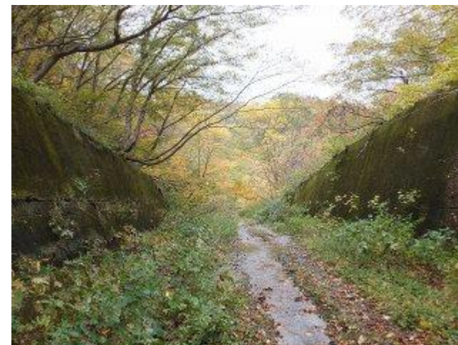
51 ニツ小屋隧道米沢側、トンネルの大漏水は万世大路を沢のようになって流れ下る。
