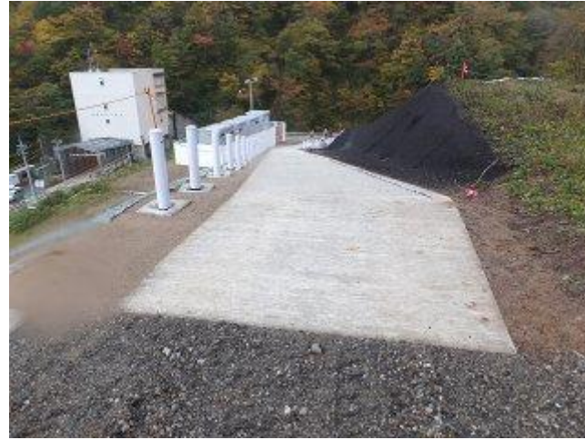
5. 旧大滝運搬路代替通路、左東栗子トンネル福島側坑口
