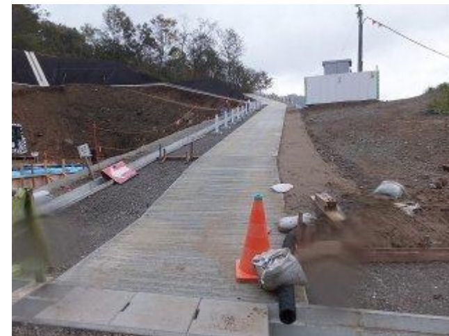
3. 旧大滝運搬路代替通路、左栗子トンネル換気坑坑口（工事中）。 写真の通路先に旧大滝運搬路がある。
