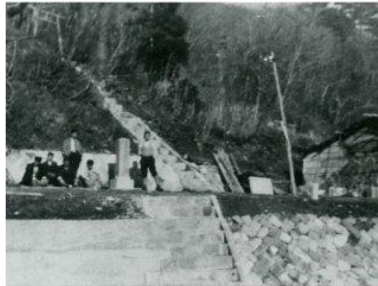
45 【参考】ニツ小屋隧道福島側、左の石碑は鳳駕駐蹕之蹟、中央の階段は山神への参道、右側の建物は倉庫(推定)。昭和 8 年。
