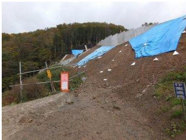
1. 旧大滝運搬路上り口（東栗子トンネル福島側坑口右）。 旧万世大路には換気坑取付道路（工事中）の作業員用通路を利用して登る。
