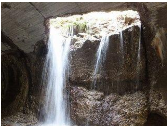
49 ニツ小屋隧道 米沢側坑口付近 大漏水 H251027
