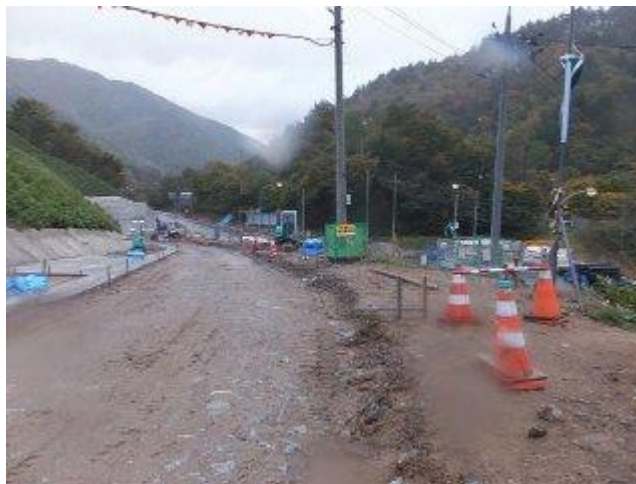
2. 換気坑取付道路（工事中）、右側作業員用通路上り口。
