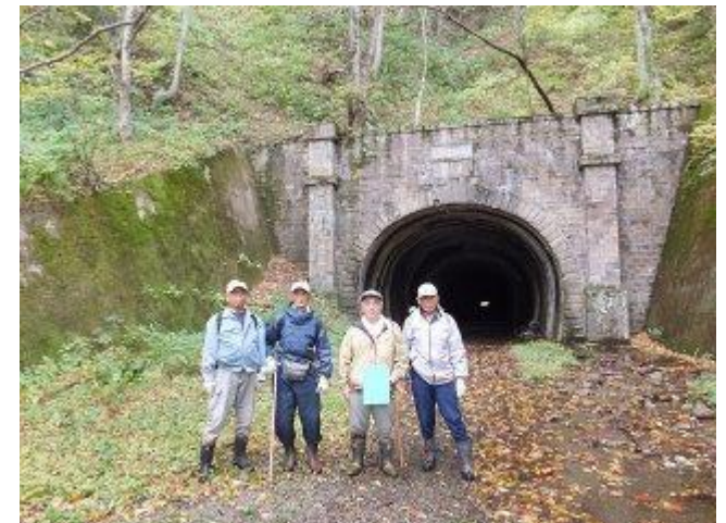
48 ニツ小屋隧道(福島側坑口)にて
