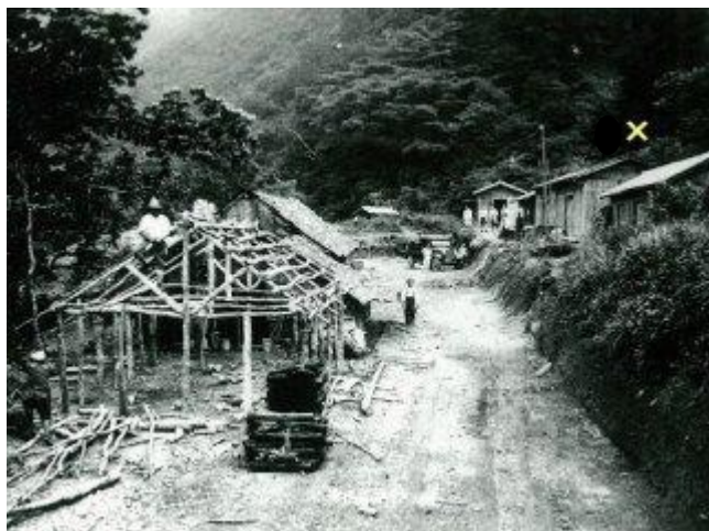
44 【参考】昭和8年頃の二ツ小屋隧道福島側の状況。左側建設中の作業員宿舎、右側見張所(出張所)等。右上の×印は二ツ小屋隧道福島側坑口
