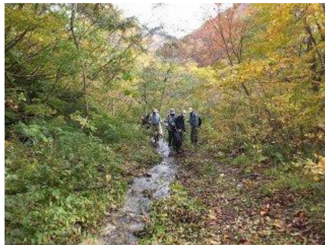
65 米沢側(大平峠)からヘアピンカーブ箇所を望む。旧道が沢となっている。洗掘が進めば万世大路は失われる可能性がある。水流の状況を確認する大滝会の皆さん。
