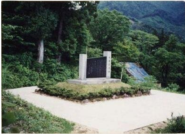
添付写真－7① 大滝記念碑敷地舗装工事完成 平成元年 5 月(大滝会 HP より)
