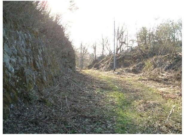
参考写真-9⑧ 万世大路開通後(M14.10.3)間もなく崩落した大桁隧道跡の掘割(切通)。東方(福島側)から西方(米沢側)を望む。H160417 (dark-Rx さん提供)
