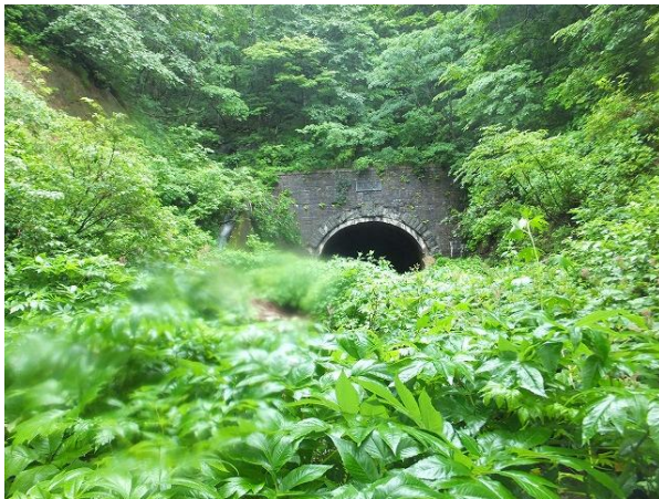
参考写真-6⑨ 緑に埋もれる最近の栗子隧道福島側坑口 H280626
