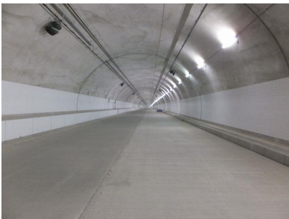
写真-11⑨ 新栗子トンネル 県境付近 山形側を 望む。この辺り最高点 459.5m(標高) H290629
