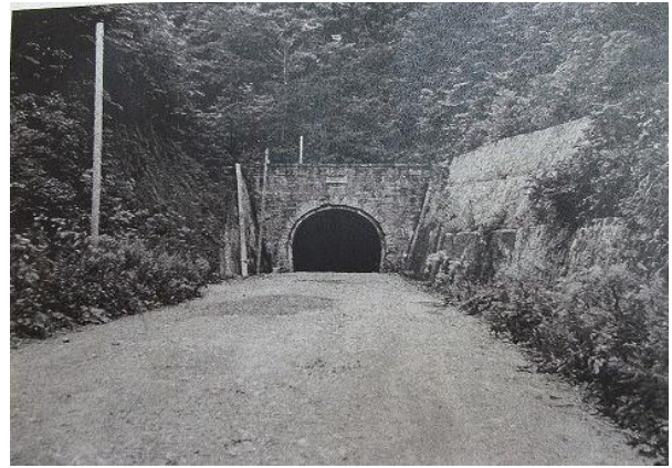
参考写真-6⑧ 栗子隧道福島側坑口 昭和 41 年 9 月頃 (「万世大路開通 130 周年記念フォーラム 資料より)
