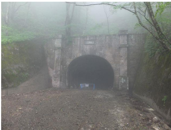
写真-6① 霧に煙るニツ小屋隧道(福島側坑口)H290525
