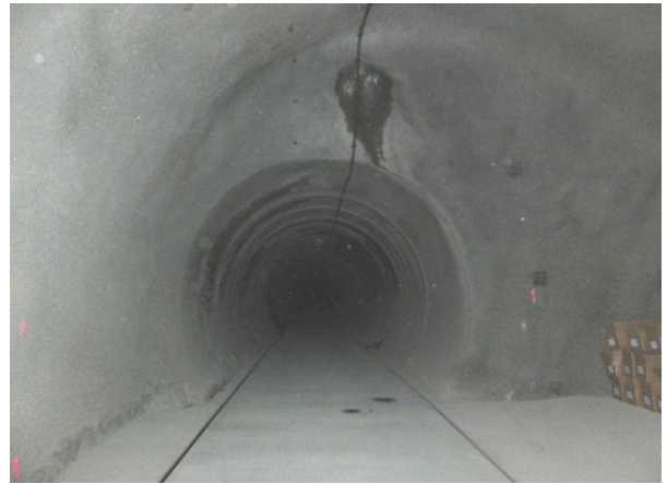
写真-11⑥ 避難坑(避難用トンネル坑内) 非常口(右側)から福島側を望む。 (⑤写真の内部)
