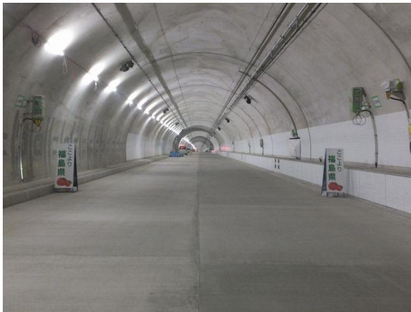
写真-11⑦ 新栗子トンネル 県境 福島側を望む (福島県分 L=5417m、山形県分 L=3555m) H290629
