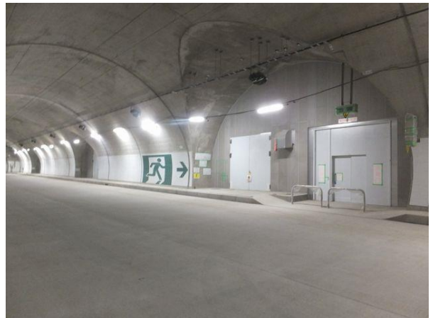
写真-11④ 新栗子トンネル STA157+60 付近(福島側から約 4570m)山形側を望む。右側手前車道・人道用避難坑連絡路(非常口)兼電気室(奥)。写真奥2箇所は単独電気室。H290629
