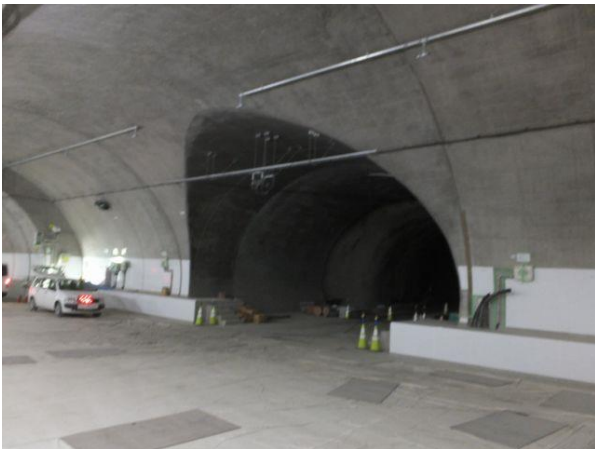
写真-11③ 換気坑(L=2609m)、中間点(4486m)左側に設置。出口換気塔に設置された2台の排風機で排気。H290629
