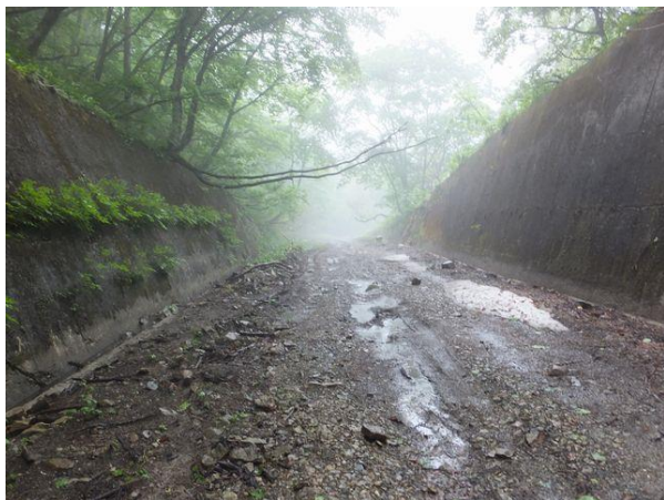
写真-8① ニツ小屋隧道米沢側坑口。 僅かに残る残雪。H290525
