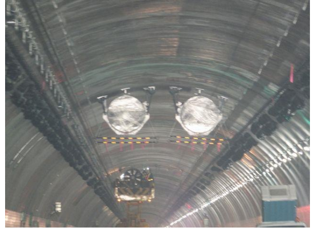
写真-11② 福島側のジェットファン(排気用)設置工事中。山形側を望む。H290629
