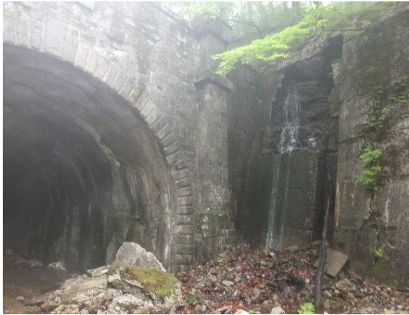
写真-6③ ニツ小屋隧道米沢側坑口。左側は崩落続く内巻コンクリートの状況。右側は沢水が流下する豎溝(跡)。トンネル上部の白竜沢(仮称)の付替水路が復活(土石撤去)し豎溝へ流れ、覆工崩落箇所からはほとんど水流なし。 H290525
