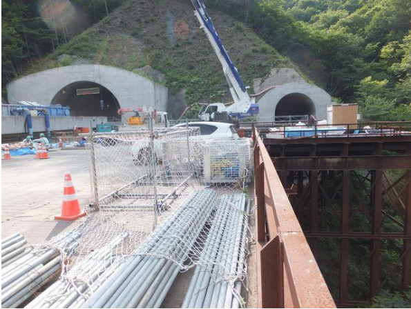
写真-11① 仮称新栗子トンネル(L=8,972m、W=9.5m(車道幅員 7m))福島側坑口。右は避難用トンネル(L=8,989m)H290629
