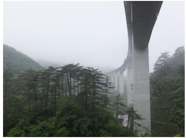
写真-13 霧に煙る東北中央自動車道中野大橋 (L=754m、H24.3 完成) 横川林道から米沢側を望む。H290525
