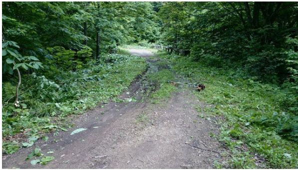
写真-5③ 6月状況:烏川橋付近除草状況 岡部達也様提供 H290617
