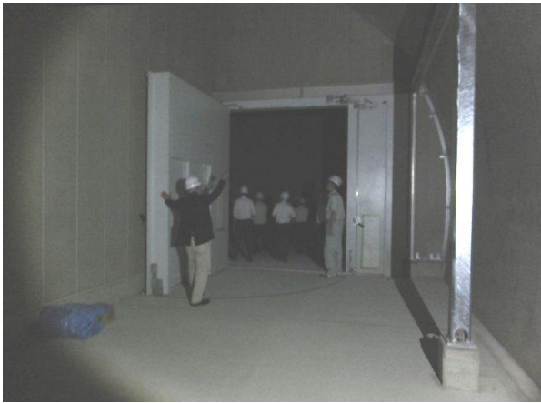
写真-11⑤ 車道・人道用避難坑連絡路 (④写真の非常口内部)。 扉の先が避難坑(避難用トンネル)。
