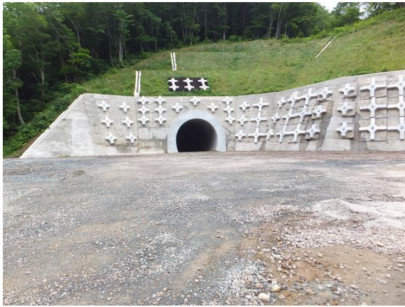
写真-11① H28.3 完成した換気坑出口（現国道13号東栗子トンネル福島側坑口付近）。現在は坑口前に換気塔建設中。H280626
