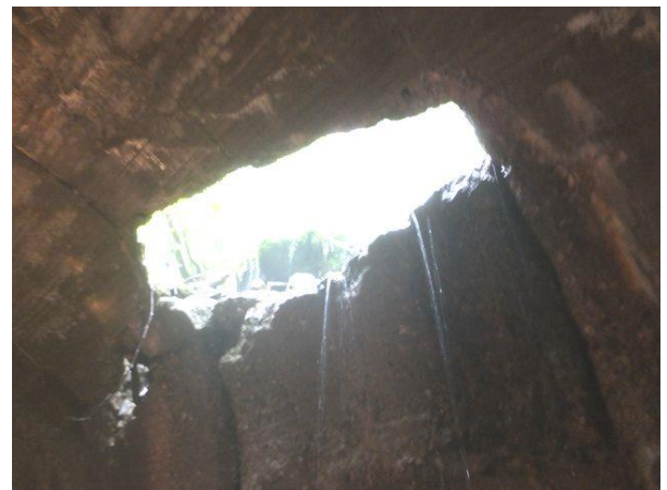
写真-7② 覆工崩落箇所からは僅かな流水。H290525
