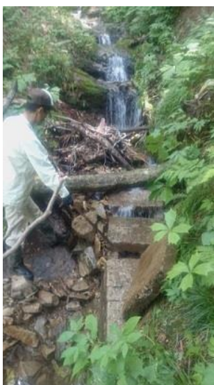
写真-7③ 白竜沢付替水路の流木土石撤去。岡部達也様提供 H280809
