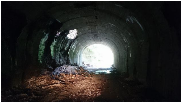
写真-7① ニツ小屋隧道米沢側崩落状況 岡部達也様提供 H290617
