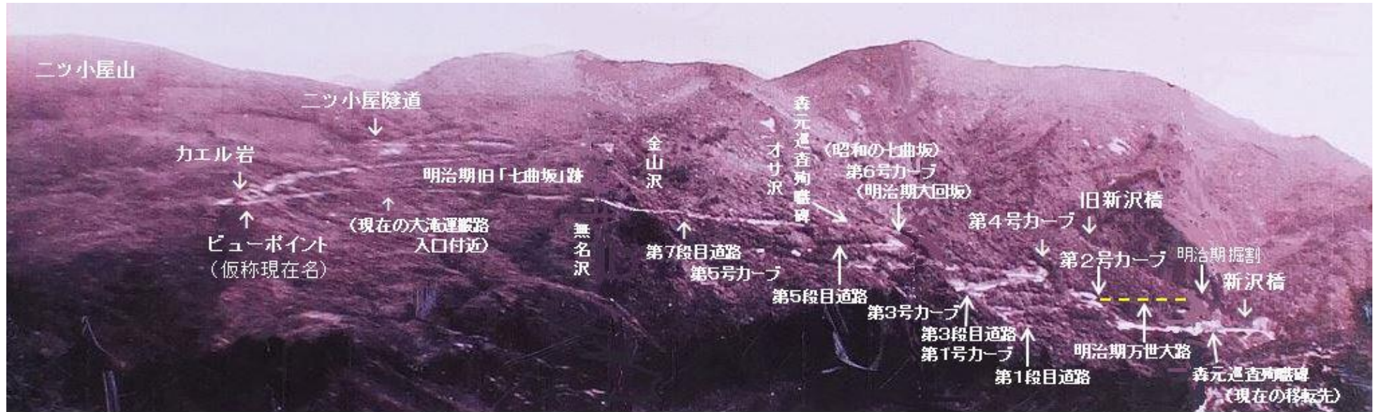
巻末参考写真-1 旧国道13号(万世大路)、ニツ小屋隧道～新沢橋間全景(昭和の大改修区間)。オクモダ沢(東栗子Tu左側)とデドモダ沢(新沢橋南向い)中間点炭焼箇所から望む。昭和31年10月11日大滝会副会長高野英治氏撮影提供
