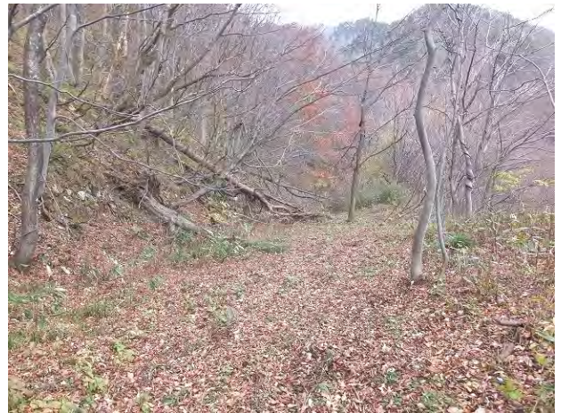
写真-42④ 第1段目道路(西側部分)、新沢橋方向を望む(3)。倒木あり。
