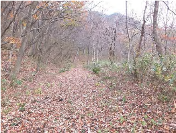
写真-42① 第1段目道路(西側部分)、第1号カーブ付近から新沢橋方向を望む(1)。昭和の大改修によるバイパス道路。
