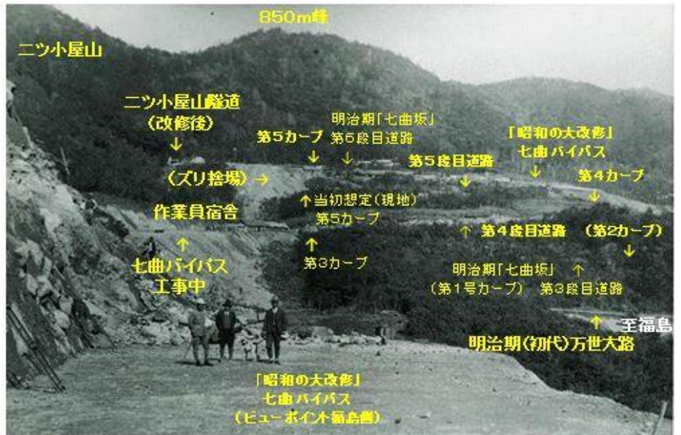
巻末参考写真-3 昭和の大改修工事中の「七曲バイパス」と旧「七曲坂」全景。(ニツ小屋隧道福島側坑門はS8.12月完成)昭和9年6月頃
