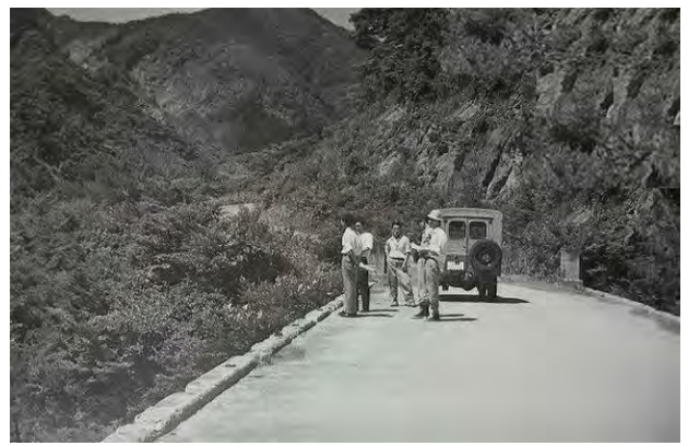
参考写真-26 高欄のない新沢橋。優雅な鑄鉄製高欄(参考写真-25参照)は、戦前昭和16年(1931年)8月の「金属回収令」により供出された。無高欄の状態で30年代半ばまで供用。昭和31年(1956年)夏の福島工事事務所の現地調査。小林泰夫調査課長(左二人目)、山谷外行技術員(右二人目)
