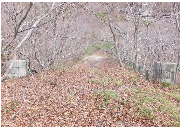
写真-44① 新沢橋米沢側から望む。本橋は3代目。初代新沢橋はL=14.5m、w=6.4mの木造土橋で本橋から200m上流に明治時代(M10.10~M14.6の間)に架設された。2代目は橋台橋脚がコンクリート製(参考写真-24参照)で上部工は木造土橋 L=20mに初代箇所では架け替えた(昭和4年頃と推定)。
