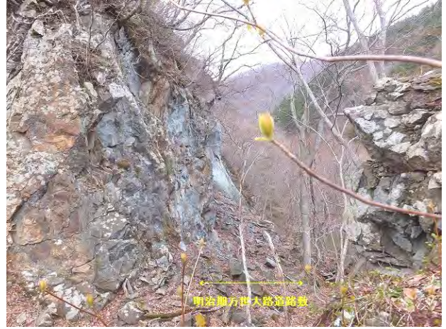
参考写真-22 明治期初代万世大路・掘割、米沢側から福島側を望む。写真中央岩盤崩壊箇所が「巨岩ノ挺出」跡と思われる。旧道は、崩落土で覆われているため通り抜けできない。H250427(2)
