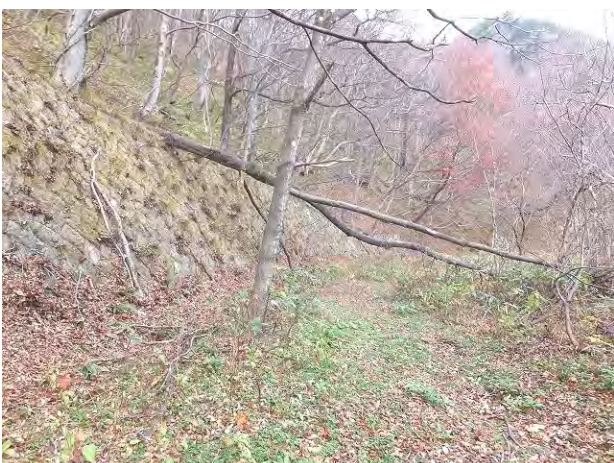
写真-42⑤ 第1段目道路(東側部分)、新沢橋方向を望む(4)。間知石積(空積)と倒木。
