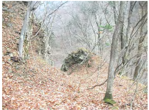
参考写真-20 入口(第2号カーブ)から150mほど進んだ峰先に掘割が造られている。写真の奥が新沢。昭和期新沢橋米沢側直上。明治期万世大路にて、米沢側から福島側を望む。H241129
