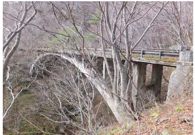
写真-44② 昭和の大改修鉄筋コンクリートアーチ橋「新沢橋」(L=42m、W=6m)S10.4~S11.12、C=18千円。内務省職員(後福島国道改良事務所長、関東地建局長)和里田新平氏設計による。福島側下流より望む。
