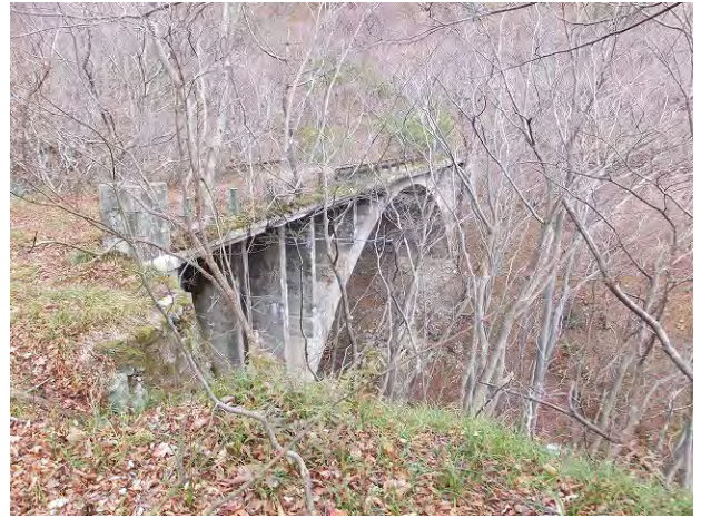
写真-44④ 米沢側下流より望む。
