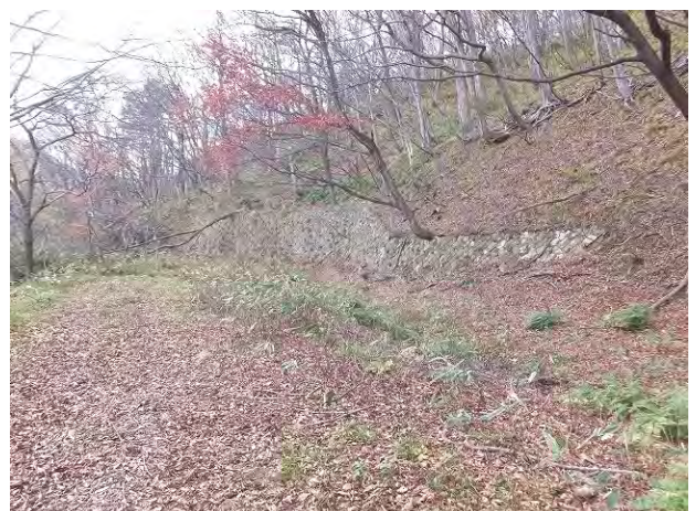
写真-42⑥ 第1段目道路(東側部分)、第1号カーブ方向を望む(2)。見事な間知石積が続いている。
