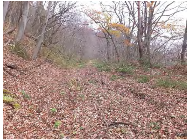
写真-40④ 「昭和の七曲坂」第2段目道路全景・第1号カーブ(福島側)から第2号カーブ(米沢側)望む。
