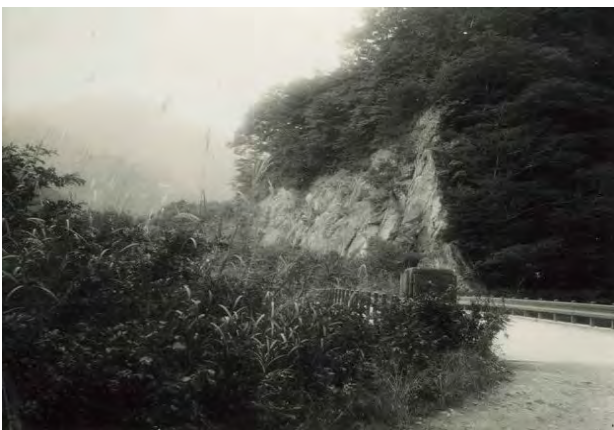
参考写真-27 ガードレール高欄が取り付けられた新沢橋。米沢側を望む。 (昭和36年9月26日、大滝会榎木新吉さん撮影提供)
