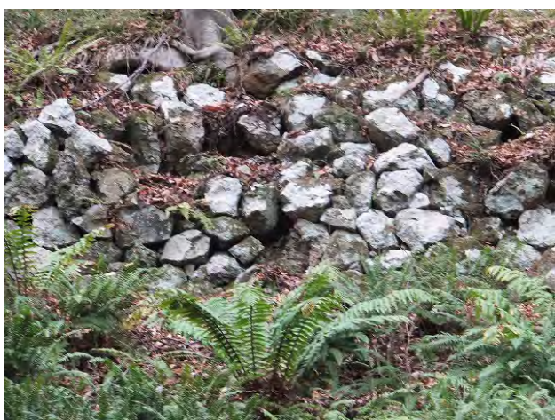
写真-38⑥ 割石積と見られる石積(空積(からづみ))。比較的新しく見えるので、昭和の大改修において施工した可能性もあるが明治期施工のものと仮定しておく。
