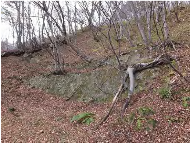
写真-37① 「昭和の七曲坂」第3号カーブ。第4段目道路側から望む。間知石積(練積)が施されている。
