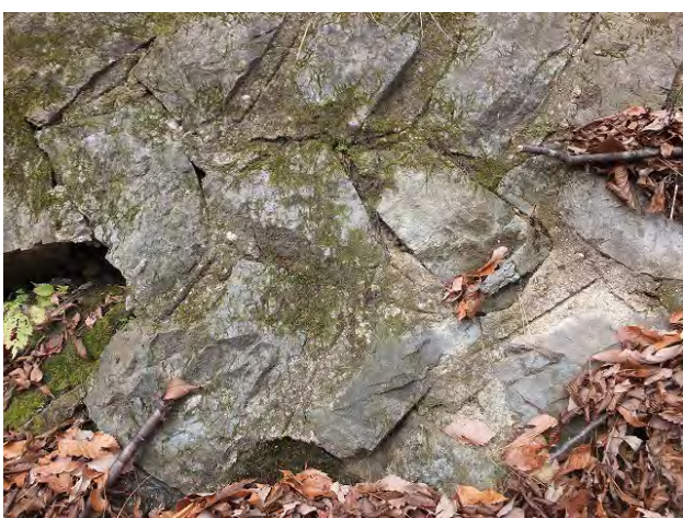
写真-37⑤ 間知石積(練積(ねりづみ)) 近接写真。目地や胴込にコンクリートが使用されている。
