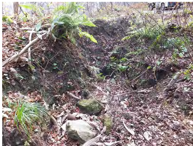
写真-29④ オサ沢、旧万世大路国道13号横断部(暗渠)。以前は人がやっと通れる幅であったが現在軽自動車クラス通行可。
