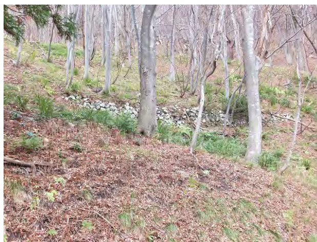
写真-38⑤ 割石積と見られる石積。第4段目道路の盛土法尻を押さえたものか。老杉大木のすぐ東側。第3段目道路から望む。
