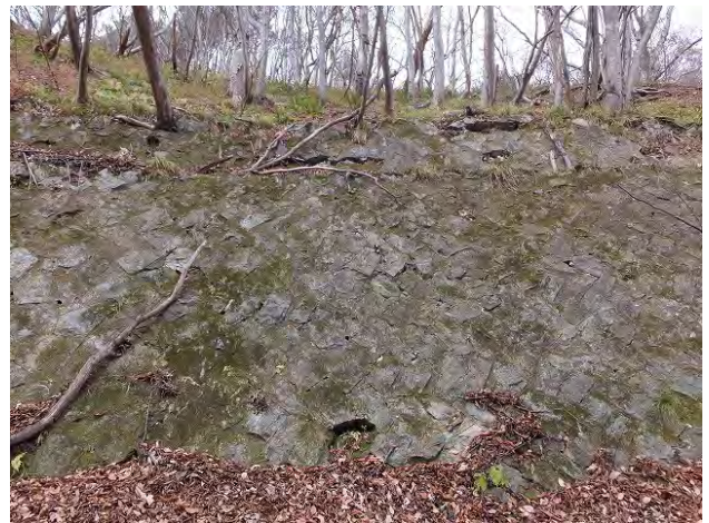
写真-37④ 第3号カーブ、間知石積(練積)
