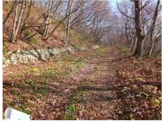
写真-8③ 「昭和大改修」で新しく設置された道路「七曲バイパス」、想定第3号カーブの直上付近から第4号カーブ方向(米沢側)を望む。見事な間知石積(空積)が見える。
