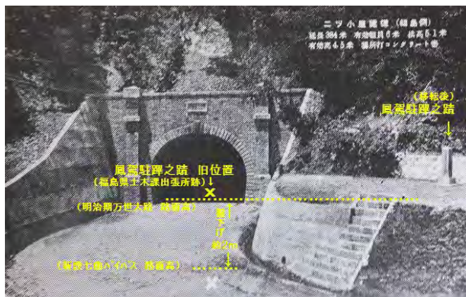
参考写真-11 「昭和の大改修」で改修されたニツ小屋隧道福島側坑門と移転された石碑(写真右端「鳳駕駐蹕之蹟」)。移転前は、バイパス路面から約 2m 上方の明治期万世大路付近(×印箇所、移転先とほぼ同じ高さ)にあり。昭和 10 年頃、『工事誌』から転載加筆
