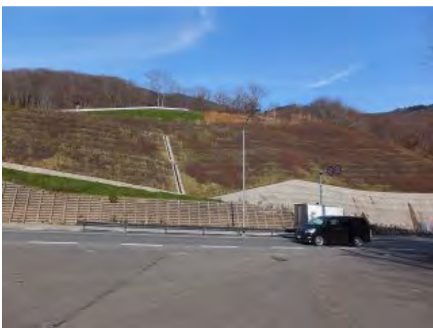
写真-1 大滝連絡路上り口。東栗子トンネル福島側坑口左側駐車帯から望む。
