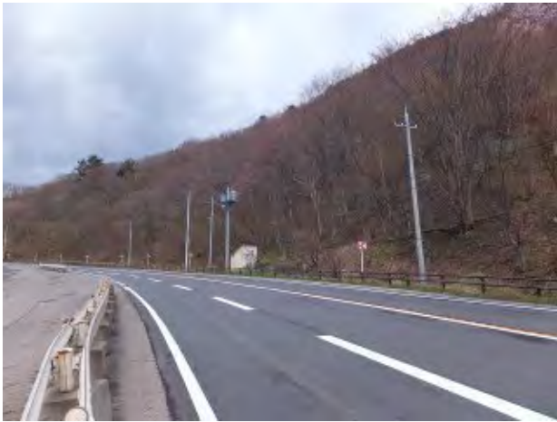
参考写真-9 現道(ニツ小屋)駐車帯から観測小屋(CCTV塔)を望む。当該箇所旧国道(すぐ上)への取付道路箇所があった(現在閉鎖)。福島側から米沢側を撮影。H250426
