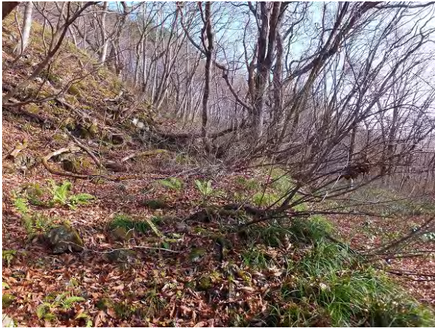
写真-12 「明治期」第6段目道路、第6号カーブ方向を望む。当該道路は、写真左上の昭和の大改修「七曲バイパス」の盛りこぼしにより半分消失したと推定される。
