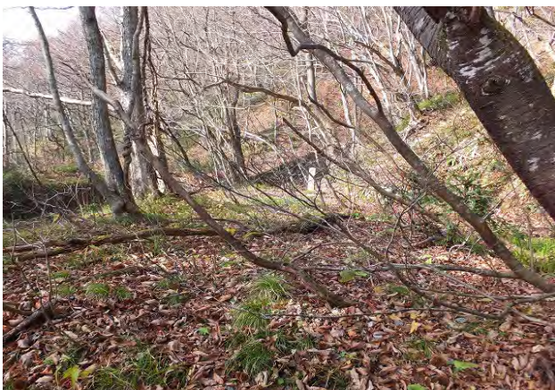
写真-14② 推定明治期「七曲坂」第7段目道路終点付近、石碑「鳳駕駐蹕之蹟」が見える。石碑の上にニツ小屋隧道福島側坑門が見える。
