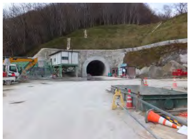
写真-2 貫通(H270727)した東北中央自動車道栗子トンネル換気坑(L=2609m)、工事用道路から望む。
