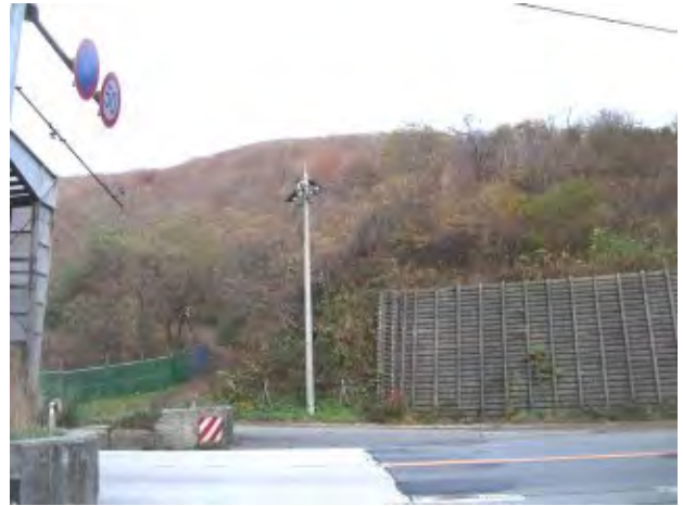
参考写真-10① 旧国道への連絡路元の入口(飯坂スキー場工事用道路若しくは林道)。途中で旧工事用道路大滝運搬路に接続する。換気坑工事のため消滅。東栗子トンネル福島側坑口ローパー(写真左端)北隣。H231113
