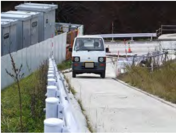
写真-3 取付坂路。換気坑工事用道路から旧大滝運搬路へ連絡。旧大滝運搬路から撮影。
