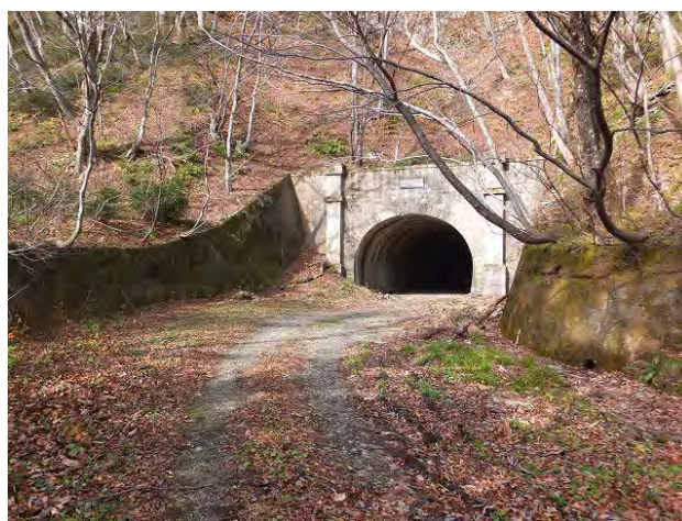
写真-15① ニツ小屋隧道福島側坑口。写真-14④の位置から隧道側を望む。
