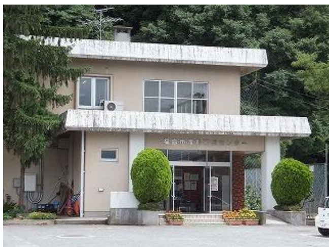
【写真-1】 福島市役所渡利学習センター
