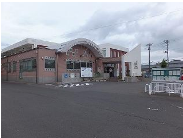
【写真-1】 福島市役所もちずり学習センター
