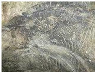
【写真-7②】 明治期栗子隧道米沢坑口のノミ掘削跡 H231001
