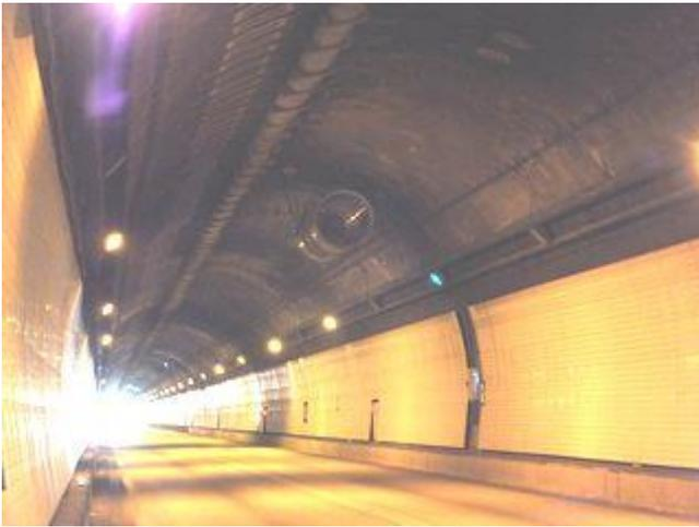
【写真-22】 東栗子トンネル天井版撤去後、ジェットファン設置状況。米沢側車両転回所から米沢側坑口を望む。H261012
