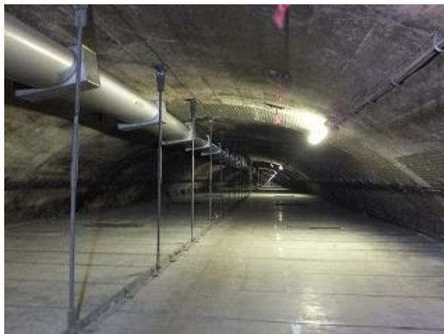
【写真-21】 東栗子トンネル天井版(写真下)撤去前、送気ダクト送風中、金具取付のリボンがなびいている。天井版撤去(補修後:中空押出セメント板(当初軽量コンクリート版))。福島坑口 50m 付近から米沢側を望む。H250925
