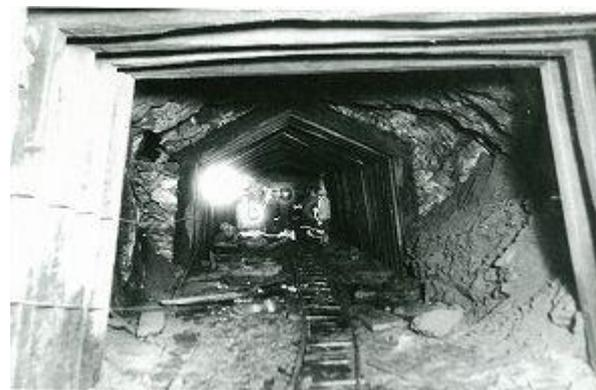
【写真-8】 『福島県是資料』の云う隧道の内部状況。改修前の栗子隧道坑内、「昭和の大改修」栗子隧道改修工事中（昭和9年）。
