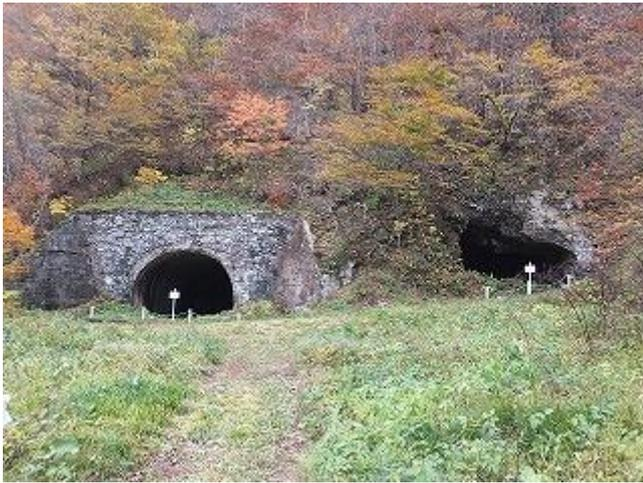
【写真-18】 並んで行む「栗子隧道」(米沢側坑口) 右側初代:明治 14 年(1881 年)9 月完成。左側 2 代目:昭和 11 年(1936 年)8 月完成。右側旧隧道は 60m 先で左側昭和の隧道に合流する。 H251101
