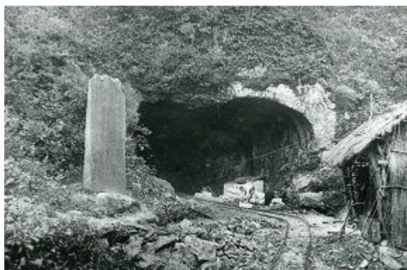
【写真-5①】明治期栗子隧道米沢側抗口(右)と「栗子隧道碑記」(左)、昭和 9 年「昭和の大改修」時(60m先の既設隧道の切払げ作業中)昭和 9 年(『工事誌』)
