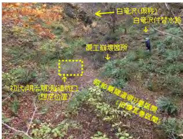
写真-60 ニツ小屋隧道米沢側坑門背面・明り巻部全景。木村会長が覆工崩落箇所を覗いている。頭の上に見えるのが白竜沢付替水路。坑門付近から望む。
