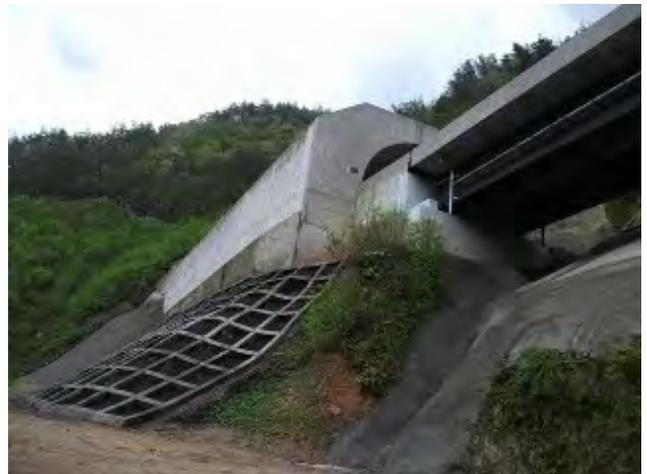
参考写真-32 東北中央自動車道中野トンネル(L=476m、H222 完成)米沢側坑口。山の中からトンネル部分が突き出ている。この突き出ている部分を明り巻（あかりまき）と云う。手前は中野第2橋(L=315m、H232 完成)H240506
