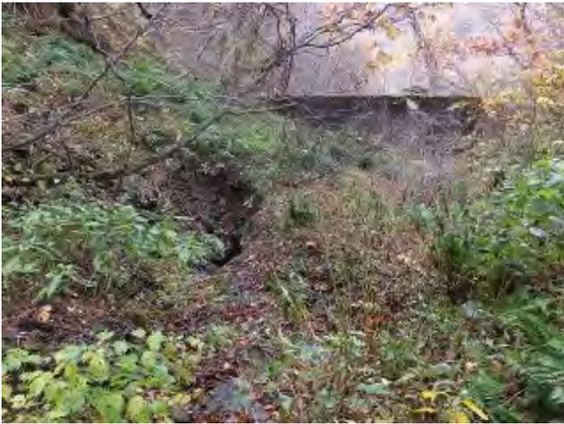
写真-63 ニツ小屋隧道米沢側坑門背面全景。左側、沢水が流入する覆工コンクリート崩落箇所。右上は坑門の面壁。
