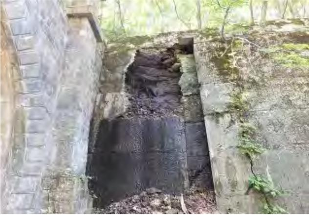
写真-56 ニツ小屋隧道米沢側坑口左側。翼壁付根付近の左側袖擁壁コンクリートの崩落状況。白竜沢(仮称)付替水路流末の堅溝が崩壊したものと推定。H260921
