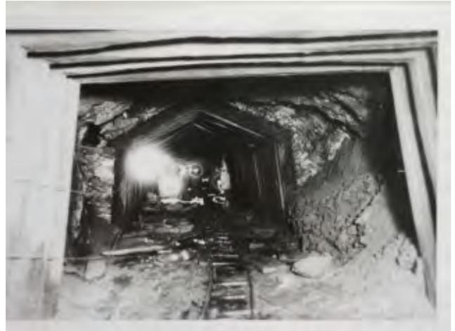
参考写真-30 初代(明治期)栗子隧道内部(「昭和の大改修」工事中)。木材支柱により補強されている。いわゆる(木巻(きまき))に相当、素掘部分も見える。二ツ小屋隧道も同じ状況だったと思われる。昭和9年頃
