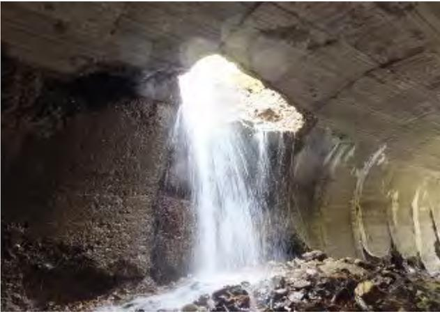
参考写真-38② 覆工崩壊箇所から流れ落ちる流水。福島側から米沢側を望む。H251027
