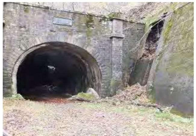
写真-55 ニツ小屋隧道米沢側坑口。内巻コンクリート剥落状況(左
