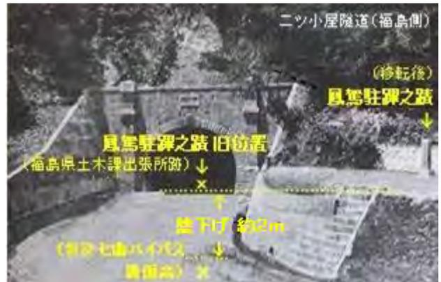
参考写真-26 「昭和の大改修」で改修されたニツ小屋隧道福島側坑口と移転された石碑(写真右端「鳳駕駐蹕之蹟」)。移転前は、バイパス路面から約2m上方の明治期万世大路付近(×印箇所、移転先とほぼ同じ高さ)にあり。昭和10年頃、『工事誌』から転載加筆
