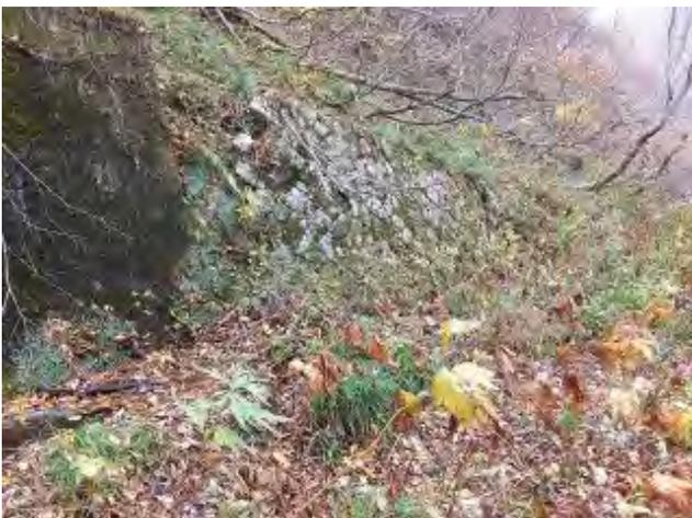
写真-58 間知石を用いた空石積箇所。写真左側の袖擁壁(練石積擁壁)に接続している
