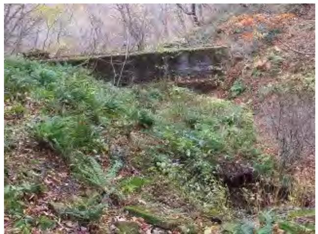
写真-62 ニツ小屋隧道米沢側坑門背面全景。右下、覆工崩落箇所。
