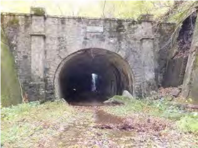
参考写真-38① ニツ小屋隧道米沢側坑口、覆工崩壊箇所から流水が滝のように流れ落ち路面を流れ下る。沢の存在を示唆。坑門右の袖擁壁箇所が元の流末と考えられるところ。H251027
