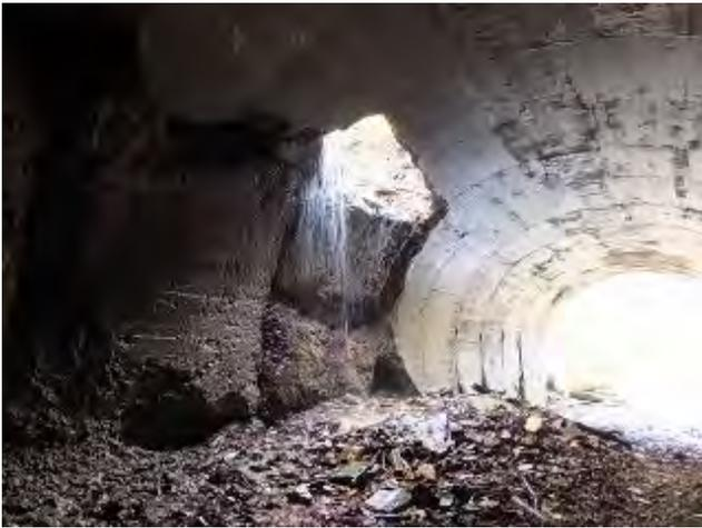
写真-54 ニツ小屋隧道米沢側坑口付近。アーチ部覆工(巻立コンクリート)崩壊箇所。沢水が流入。
