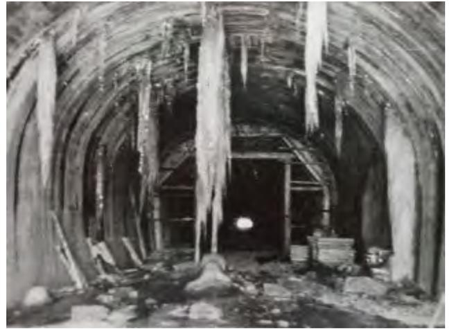
参考写真-35 ニツ小屋隧道補修工事状況(内巻)、福島県施工。昭和28年1月
