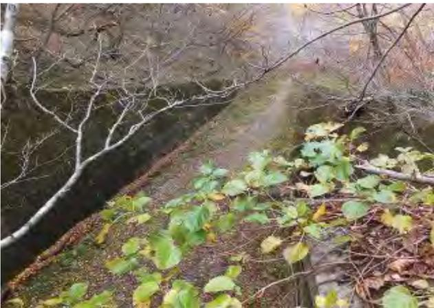
写真-57 ニツ小屋隧道米沢側坑口上から米沢側を望む。両側に「練石積」擁壁(割栗コンクリート)と、写真奥に接続して空石積が続く(延長約50m)。写真右下は坑口右側門柱頭部(四角錐)
