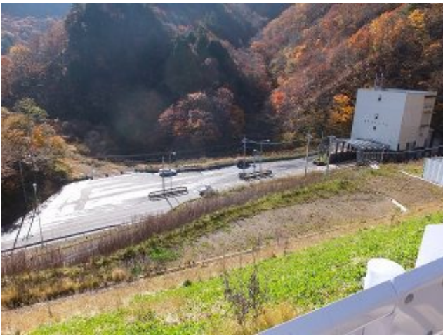
写真-5 東栗子トンネル福島側坑口付近。 左側旧大滝運搬路終点部(ガードレール仮置部分)、 右東栗子トンネル旧換気塔。取付坂路終点付近(旧大滝 運搬路上り口)から望む。
