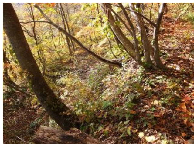
写真-24 明治期万世大路七曲 3段目道路から2段目道路(左下)を望む。
