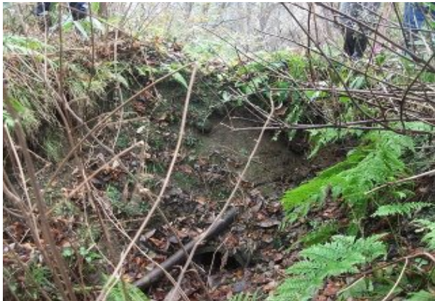
参考写真-4② オサ沢の旧万世大路を横断する暗渠。上流側から望む H241124
