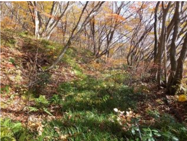
写真-31 第4段目道路、想定第3号カーブ側(福島側)から第4カーブ側(米沢側)を望む。左すぐ上は昭和の大改修「七曲バイパス」で、4段目道路に盛土されている。
