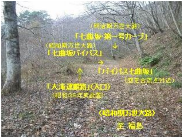
参考写真-25① 旧大滝運搬路入口付近を福島側から望む。昭和の大改修「七曲バイパス」、明治「七曲坂」合流点付近。H241124
