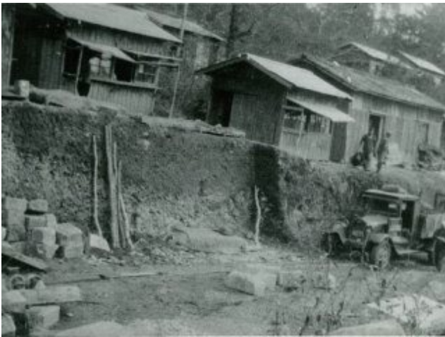
参考写真-29 七曲バイパス(下)と旧道(上)と思われる所に建つ二ツ小屋工場(出張所)と倉庫。資材運搬用の貨物自動車や旧隧道からの発生品と思われる切石が見える。左右の建物地盤に段差が見られる。昭和9年頃
