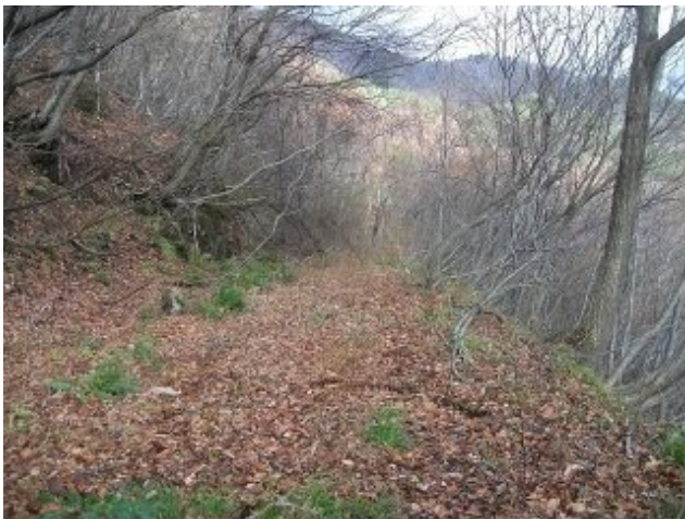
参考写真-16 カーブ箇所から殉職碑跡(第6号カーブ)方向を望む。参考写真-13の反対方向。道路の勾配が結構あることが分かる。H241124
