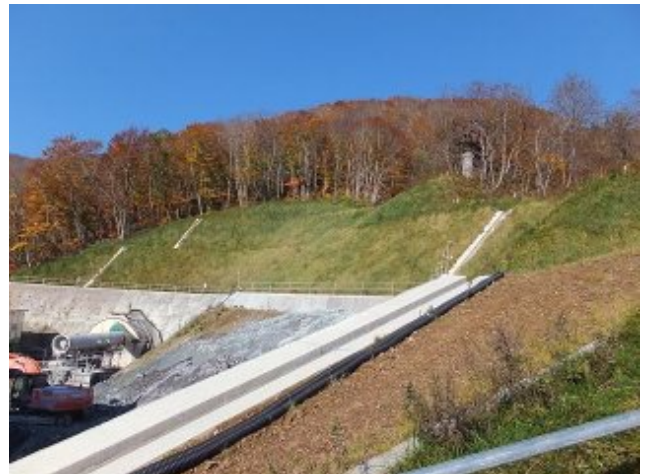
写真-3 紺碧の秋空と工事中の換気坑坑口。 写真右上に旧飯坂スキーリフト跡が見える、その少し隣りに旧大滝運搬路がある。取付坂路中間から望む。
