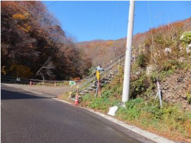
写真-1 工事用道路への歩行者用通路(作業員用臨時)を上る。 旧万世大路連絡路上り口右側。
