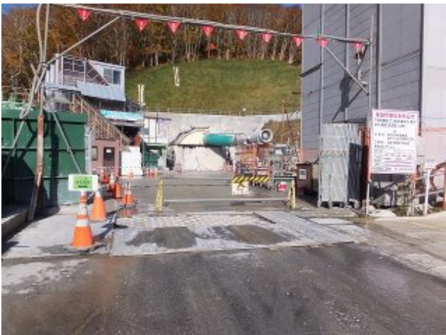
写真-2 新栗子トンネル用換気坑(2,609m)工事現場。 右側看板手前が取付坂路。「東北中央自動車道栗子トンネル換気坑工事」(請負者前田建設工業株式会社、 工期H25.3~H28.3)
