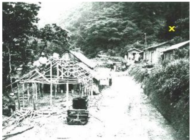
参考写真-28 ニツ小屋隧道福島側明り部。×印の下が初代ニツ小屋隧道。右は内務省ニツ小屋工場(出張所・倉庫、旧道上若しくは旧道隣接)、左は作業員宿舎(新設七曲バイパス上)昭和 8 年 7 月頃 『工事誌』から転載加筆
