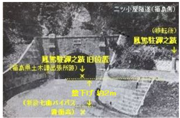
参考写真-26 「昭和の大改修」で改修されたニツ小屋隧道福島側坑門と移転された石碑(写真右端「鳳駕駐蹕之蹟」)。移転前は、バイパス路面から約 2m 上方の明治期万世大路付近(×印箇所、移転先とほぼ同じ高さ)にあり。昭和 10 年頃、『工事誌』から転載加筆
