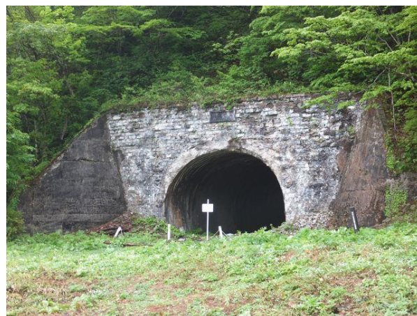
写真-2② 昭和期栗子隧道、米沢側坑口。 工事期間:昭和9年5月～昭和11年8月。 L=870m、W=6m(有効幅員)、H=4.5m(有効)・ 5.1m(中央)H290525
