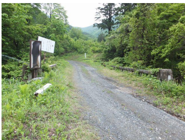
写真-1① 滝岩上橋(明治初代名称:滝ノ岩橋(石橋 L=12 間・21.8m、W=4 間・7.3m))。米沢側から福島側を望む。昭和 7 年 9 月完成(山形県施工)。奥の白い標柱は明治天皇御野立(おのだて)の地 瀧野沢、昭和の大改修 L=14.4 km(S8.4～S12.3)終点。
