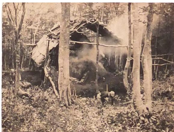
【写真炭焼-3】 木を焚いて窯を乾かしているところ（窯をつくるときに設置した木枠や支保材も併せて燃やす）。
