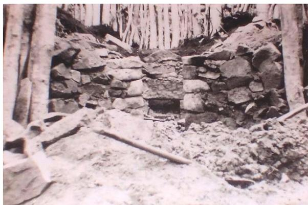
【写真炭焼-1】 手前両側に積んであるのが窯の口石。<sup>くちし</sup>奥の小さい長方形の空間はクド（煙だし）。
