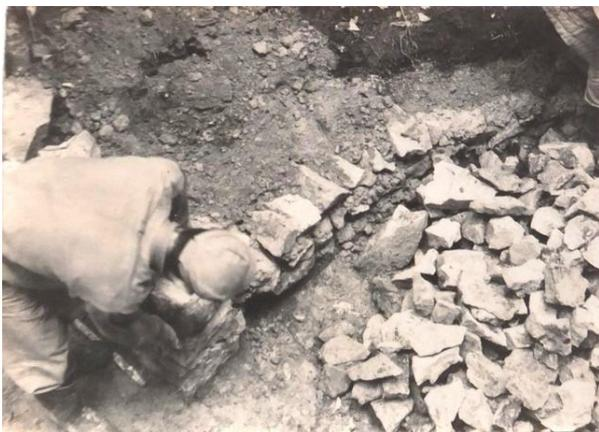
【写真炭焼-2】 窯口の口石くちいしの積み上げ作業中。
